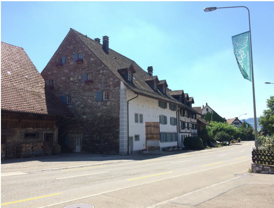
Weinbauernhaus mit Waschhaus, Weinbauernhaus (Vers. Nr. 00157), Ansicht von O, 08.08.2016 (Bild Nr. D100665_14).
