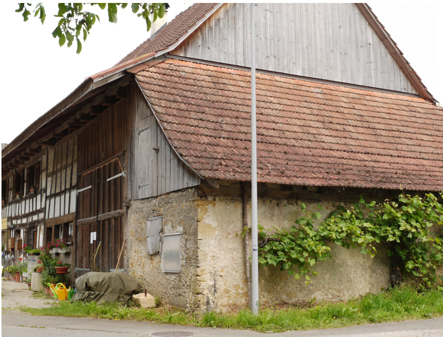
«Zunfttrichterhaus», südseitiger Kelleranbau von 1800, Ansicht von NW, 27.06.2013 (Bild Nr. D100574_06).
