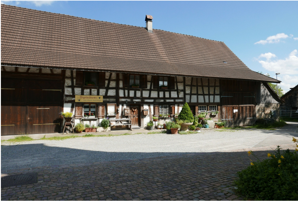
«Zunfttrichterhaus», Wohnteil um 1800 erweitert mit Stall und Tenn, Ansicht von NW, 06.06.2016 (Bild Nr. D100574_10).
