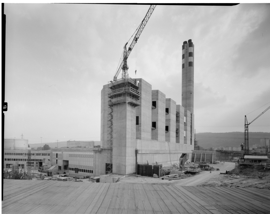
Heizkraftwerk Aubrugg, v. l. n. r. Dienstgebäude (Vers. Nr. 01953), Maschinenhalle (069HALLE01953), Kesselhaus (069KESSEL01953), Hochkamin (069KAMIN01953), rechts ist an der Fassade des Kesselhauses die Schalung für die Stützmauern zur Terrainauffüllung sichtbar, Ansicht von N, 16.09.1977 (Bild Nr. U42735).
