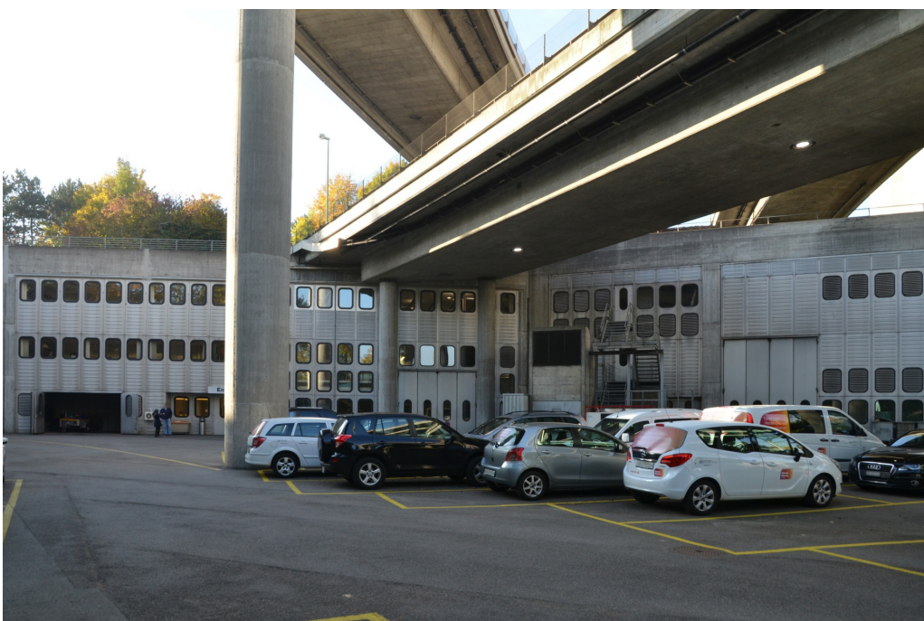
Heizkraftwerk Aubrugg, Nordhof, links Dienstgebäude (Vers.-Nr. 01953), das die Autobahnunterwerfung trägt, rechts Maschinenhalle (069HALLE1953), deren Konstruktion die beiden Autobahnüberwerfungen trägt, Ansicht von N, 16.10.2017 (Bild Nr. D100580_62).
