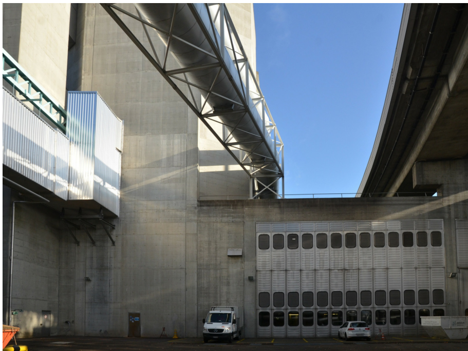
Heizkraftwerk Aubrugg, Süd Hof, links Kesselhaus (069KESSEL01953), rechts Maschinenhalle (069HALLE1953) mit den auswechselbaren modularen Aluminiumpaneelen, Ansicht von SW, 16.10.2017 (Bild Nr. D100580_69).
