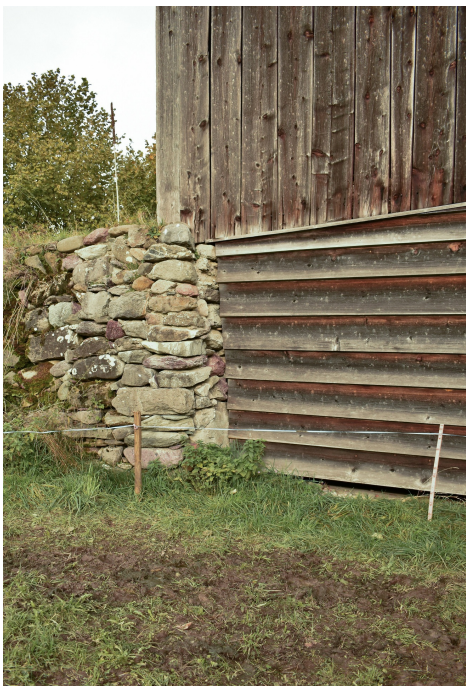
Feldscheune Burstel, Rampe auf trocken geschichteten Natursteinen, Übergang zur Hocheinfahrt, Ansicht von SW, 04.11.2022 (Bild Nr. D100692_95).
