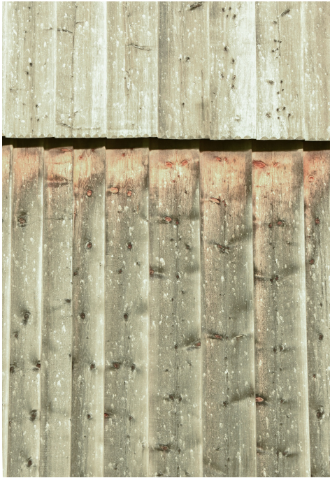
Feldscheune Burstel, gegen SO überlappende, wettergerechte und verzierte Holzverkleidung an der Südwestfassade, 04.11.2022 (Bild Nr. D100692_94).
