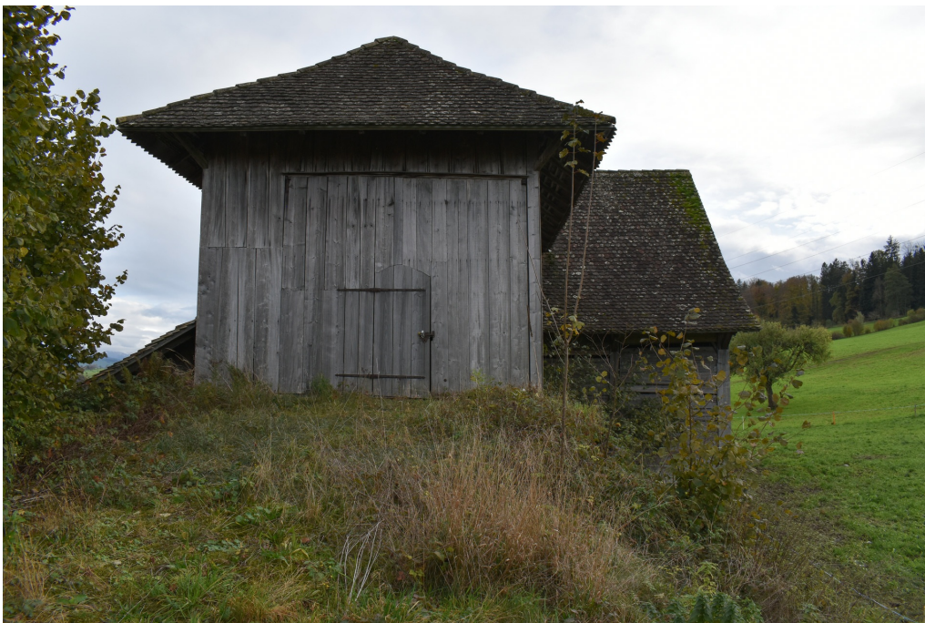
Feldscheune Burstel, Ansicht von NW, die Hocheinfahrt, 04.11.2022 (Bild Nr. D100692_99).
