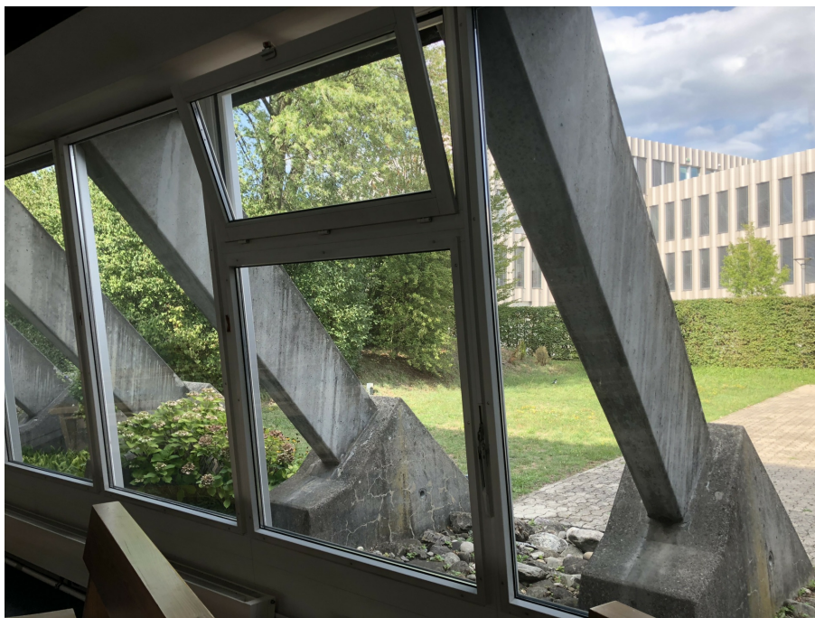
Kath. Kirche Bruder Klaus, Blick vom Kircheninnenraum auf die Betonbinder mit Widerlagern im NO, 29.08.2018 (Bild Nr. D101399_17).
