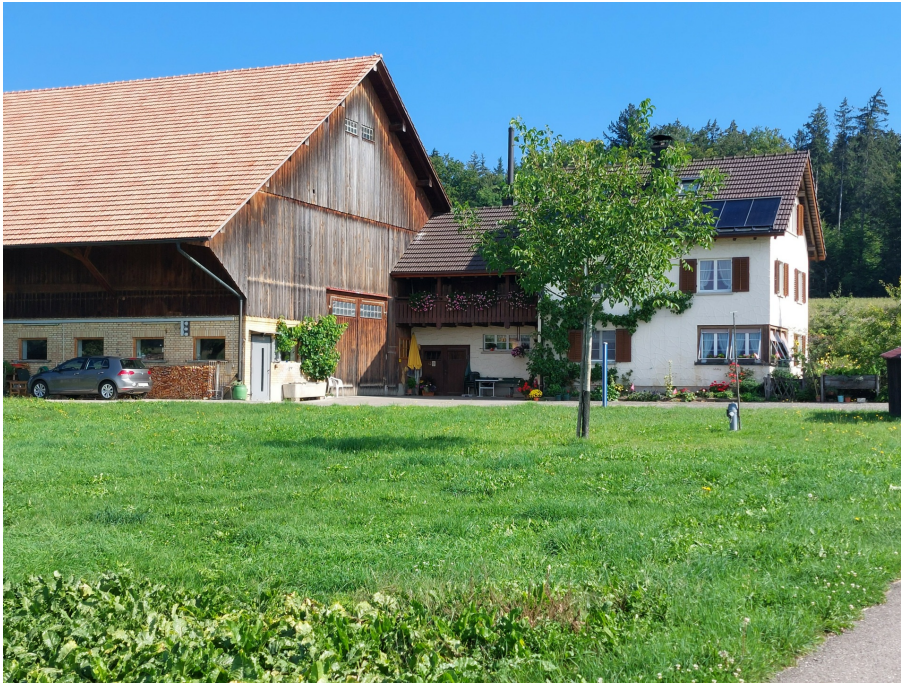
Zelglihof, grosse Stallscheune, Zwischenbau und Wohnhaus, Ansicht von S, 10.08.2022 (Bild Nr. D100692_82).
