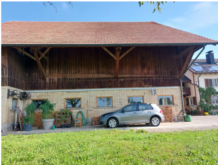
Zelglihof, vorderer Teil der Stallscheune mit Längsstall für Grossvieh, Flugpfettenkonstruktion und geschlossener Dachfläche, Ansicht von SW, 10.08.2022 (Bild Nr. D100692_87).
