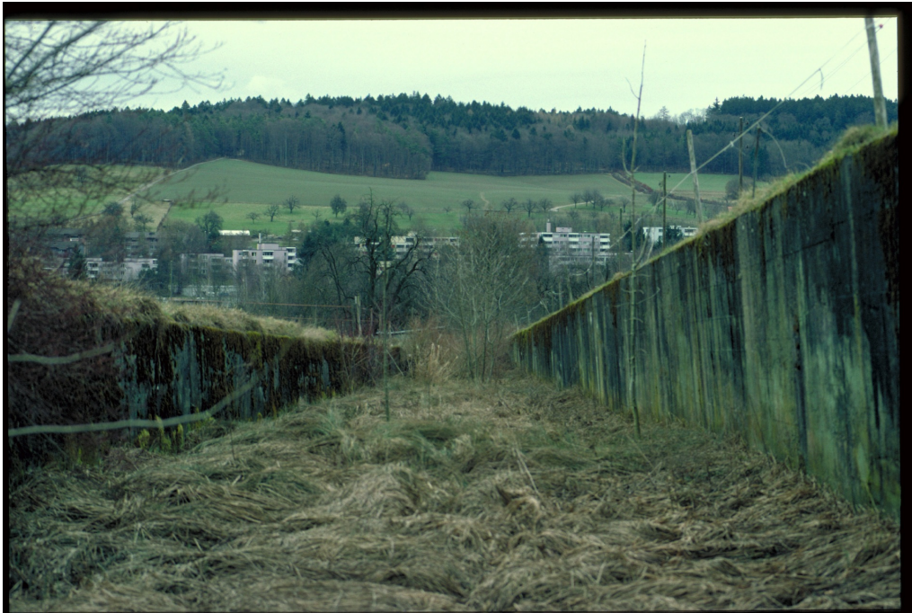
Sperrstelle 5047 Unterreppischtal (Bild Nr. D100538_99).
