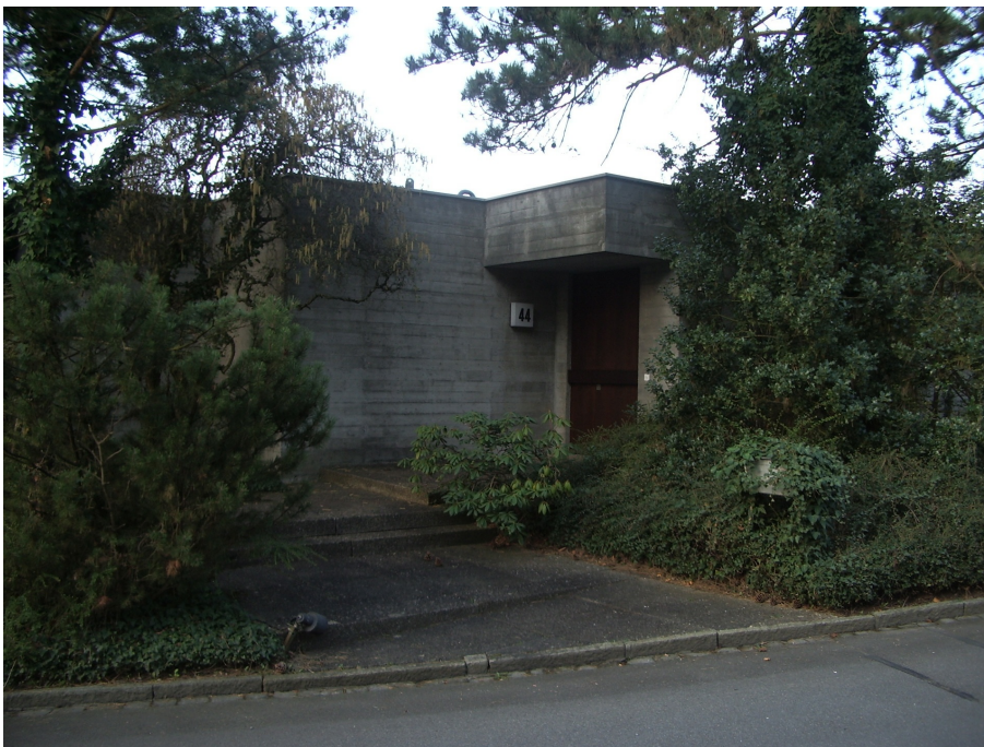
Architekteneigenheim, Ansicht von NO, 06.01.2014 (Bild Nr. D100667_43).
