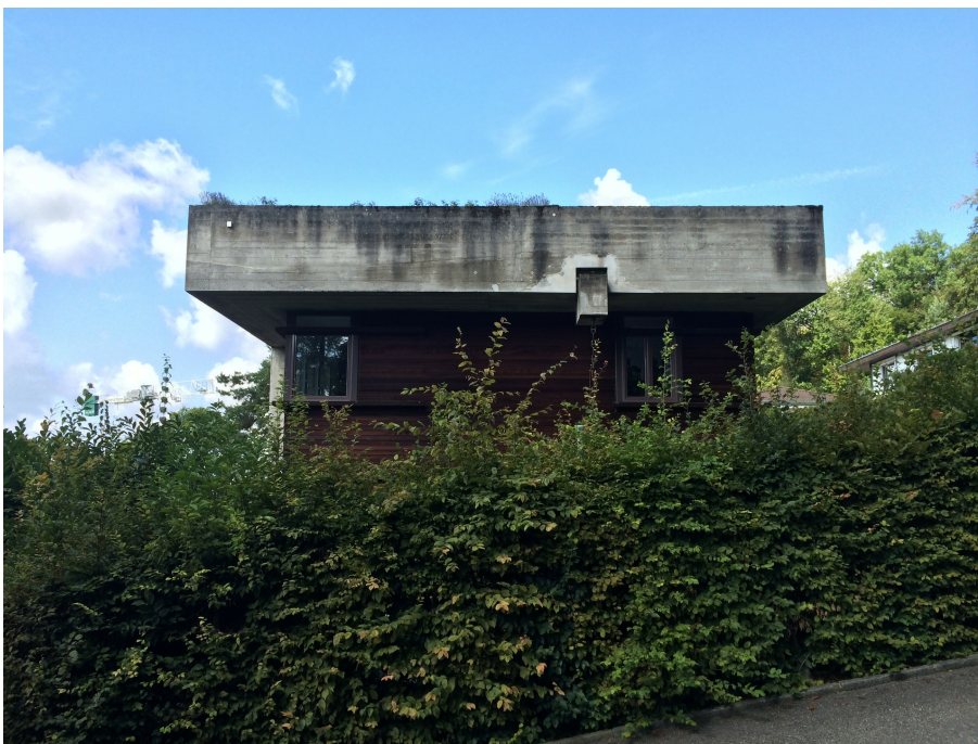
Doppelwohnhaus, Ansicht von O, 12.08.2014 (Bild Nr. D101132_94).
