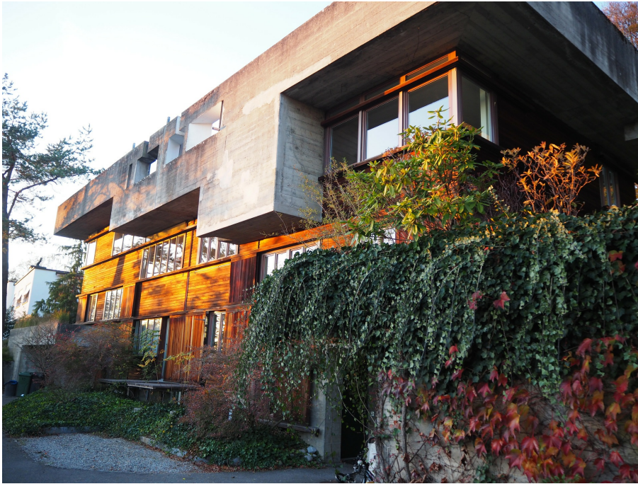
Doppelwohnhaus, Ansicht von SO, 01.11.2017 (Bild Nr. D101132_91).
