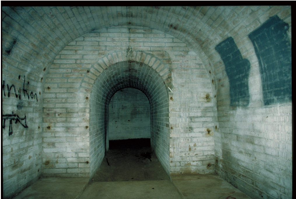
Sperrstelle 5053, Zugsunterstand A04930, 19.03.1998 (Bild Nr. D100538_78).
