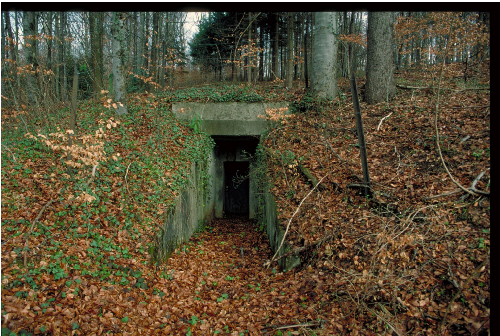
Sperrstelle 5053, Zugsunterstand A04931, 19.03.1998 (Bild Nr. D100538_79).
