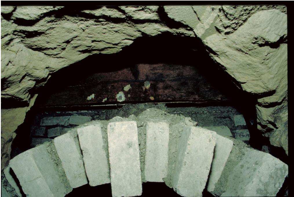
Sperrstelle 5053, Zugsunterstand A04929, 19.03.1998 (Bild Nr. D100538_74).
