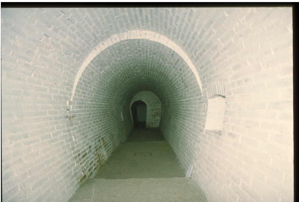
Sperrstelle 5053, Zugsunterstand A04929, 19.03.1998 (Bild Nr. D100538_75).
