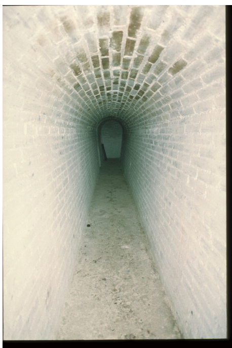
Sperrstelle 5053, Zugsunterstand A04929, 19.03.1998 (Bild Nr. D100538_73).
