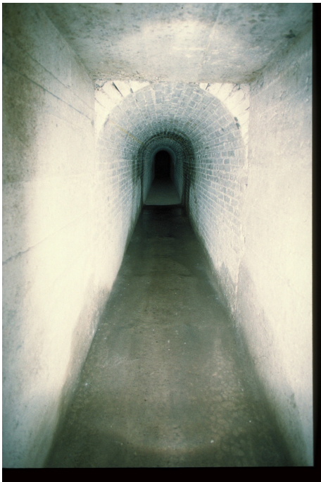
Sperrstelle 5053 Schlieren Süd, Zugunterstand A04931, 19.03.1998 (Bild Nr. D100538_80).
