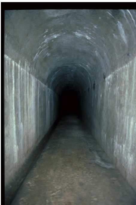
Sperrstelle 5053, Kleinunterstand A04902, 15.08.1997 (Bild Nr. D100538_71).
