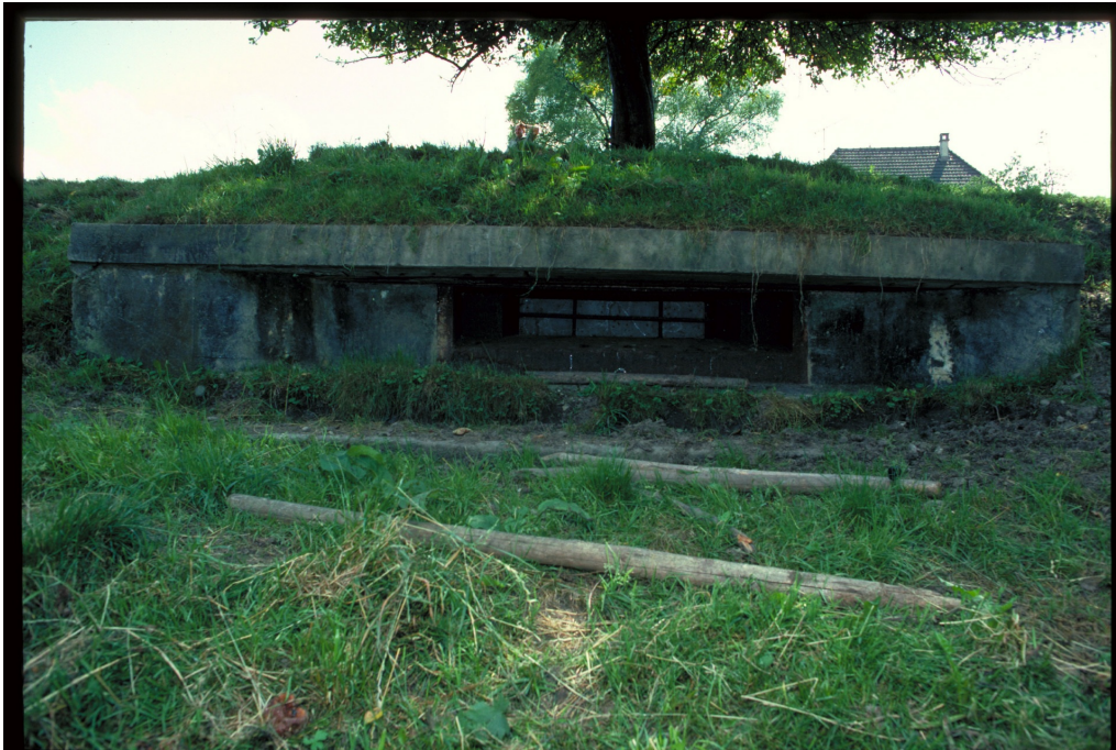
Sperrstelle 5053, Kleinunterstand A04902, 15.08.1997 (Bild Nr. D100538_70).
