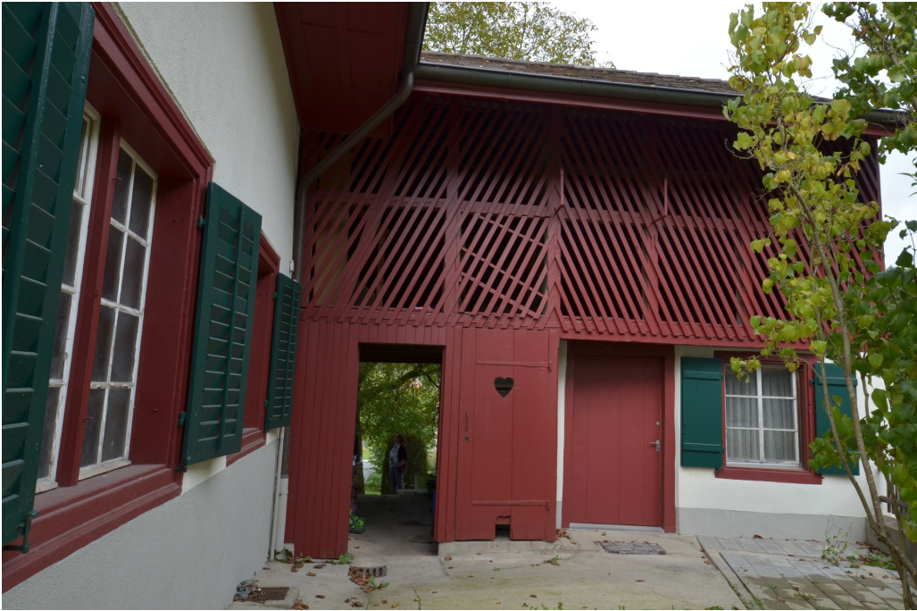
Ref. Pfarrhaus, Waschhausanbau mit Schopf, Ansicht von SO, 06.10.2021 (Bild Nr. D102609_24).
