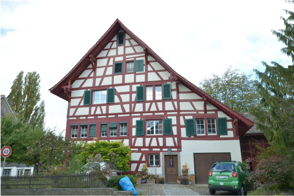
Ref. Pfarrhaus, Ansicht von SO, 06.10.2021 (Bild Nr. D102609_27).
