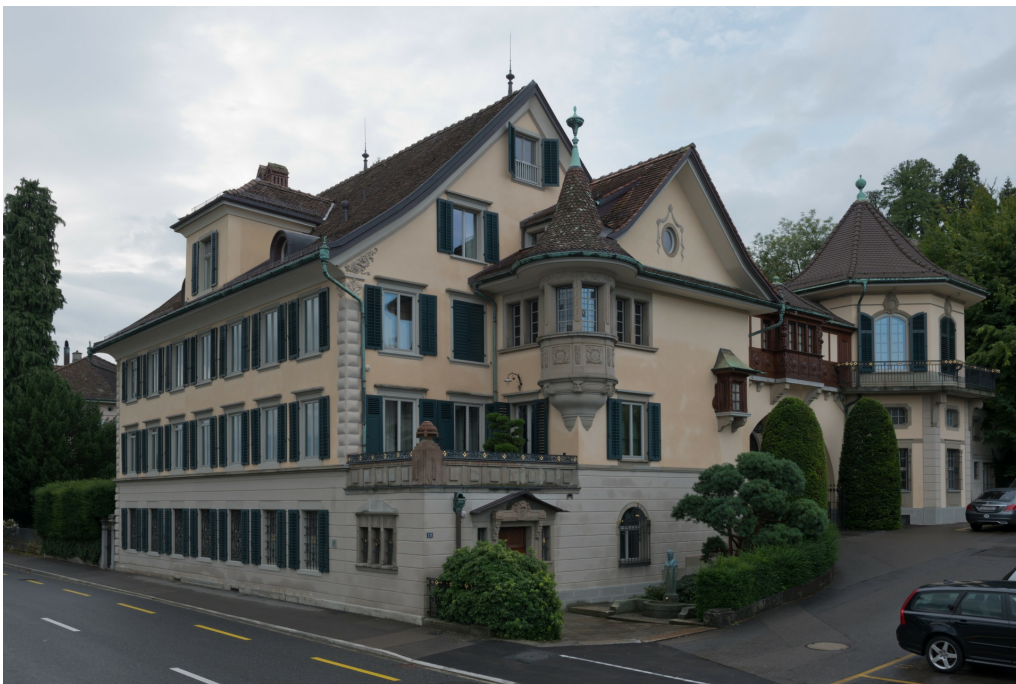
«Am Gstad», links die Villa «Am Gstad» (Vers. Nr. 00658) mit vorgelagertem Treppenhaus, rechts der Brückengang und der Turm des Nebengebäudes (141NEBEN00658), Ansicht von N, 27.08.2018 (Bild Nr. D101920_50).
