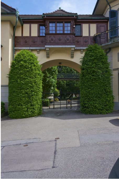
«Am Gstad», Eingang zum Hof (141UMGEBUNG00658) und Brückengang, der die Villa «Am Gstad» (Vers. Nr. 00658) und das Nebengebäude (141NEBEN00658) verbindet, Ansicht von NW, 28.05.2018 (Bild Nr. D100972_71).
