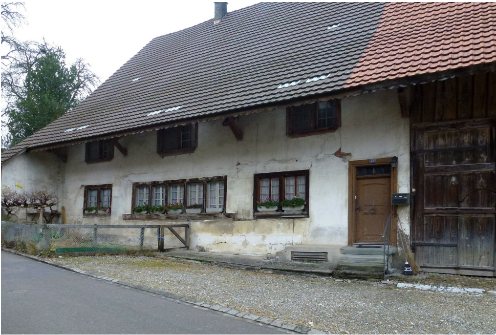
Vielzweckbauernhaus, Wohnteil, Ansicht von SO, 15.05.2015 (Bild Nr. D100580_55).
