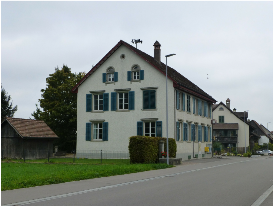
Schulhaus Windlach, Ansicht von S, 03.10.2014 (Bild Nr. D100559_61).
