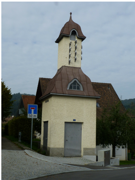
Transformatorenstation «Dorf», Ansicht von NO, 26.09.2014 (Bild Nr. D100559_21).
