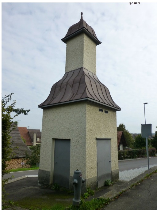
Transformatorenstation «Dorf», Ansicht von SW, 26.09.2014 (Bild Nr. D100559_20).
