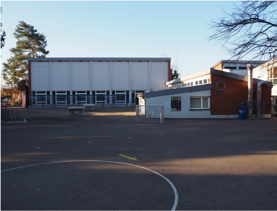
Primarschulanlage Hofacker, Turnhallentrakt (Vers. Nr. 1252), Ansicht von SO, 07.12.2017 (Bild Nr. D101131_64).
