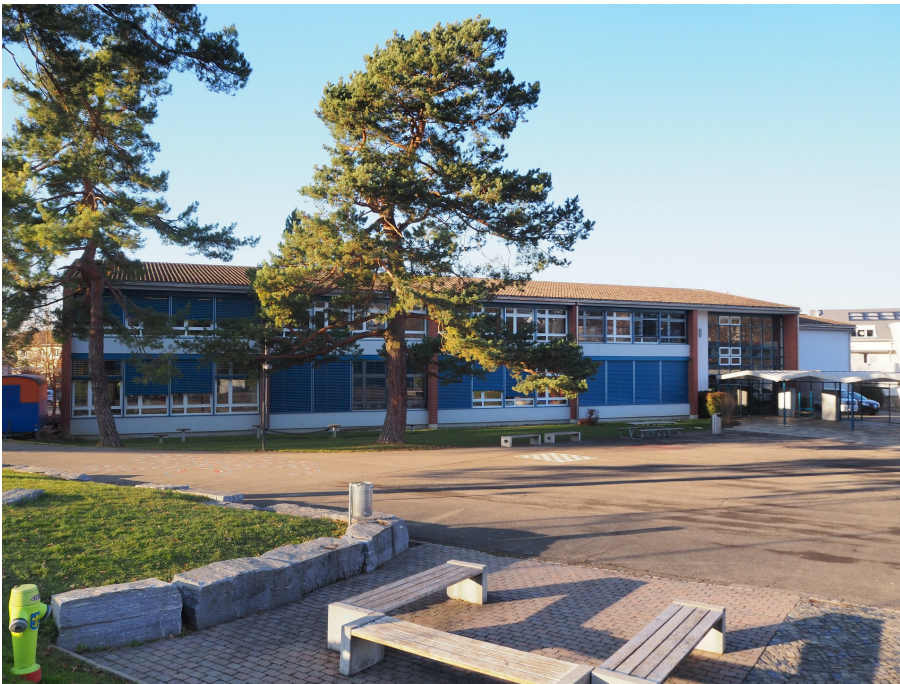
Primarschulanlage Hofacker, Mehrzwecktrakt (Vers. Nr. 01253), Ansicht von SO, 07.12.2017 (Bild Nr. D101131_65).
