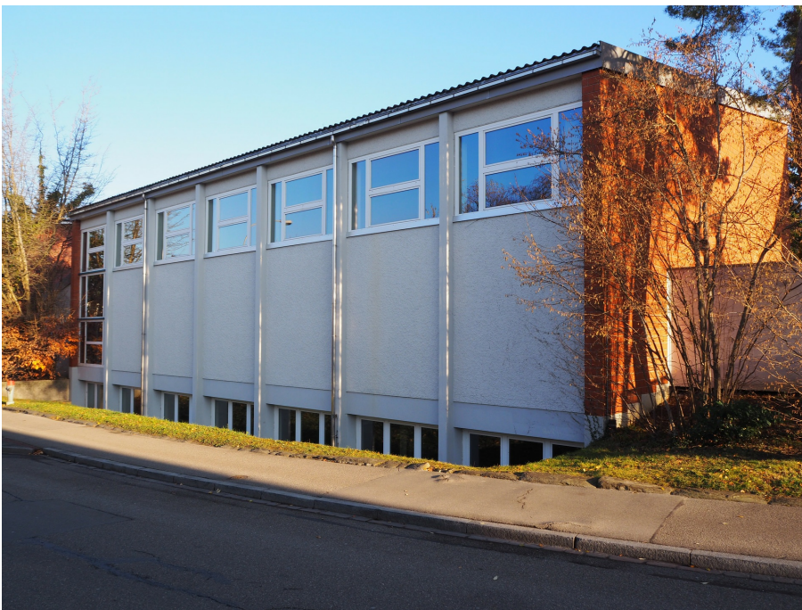
Primarschulanlage Hofacker, Turnhallentrakt (Vers. Nr. 1252), Ansicht von SW, 07.12.2017 (Bild Nr. D101131_66).
