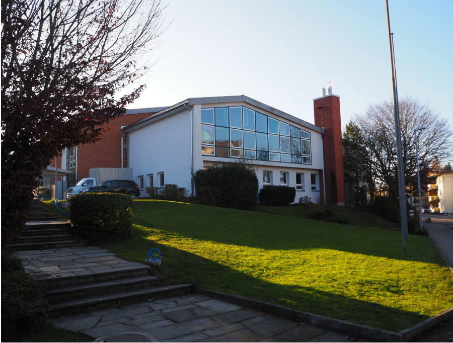
Primarschulanlage Hofacker, Mehrzwecktrakt (Vers. Nr. 01253), Ansicht von NO, 07.12.2017 (Bild Nr. D101131_59).
