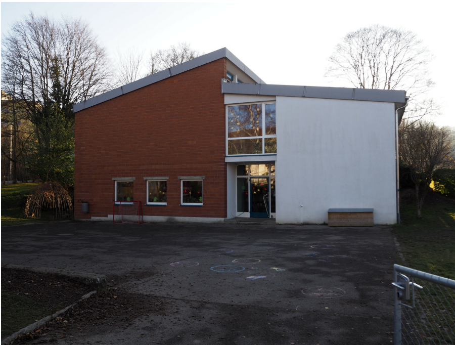
Primarschulanlage Hofacker, Schulpavillon 2 (Vers. Nr. 1255), Ansicht von NO, 07.12.2017 (Bild Nr. D101131_57).
