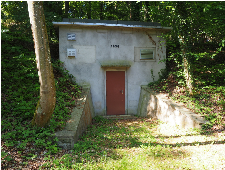
Reservoirensemble Lölmoos, Reservoir und Schieberhaus Lölmoos 2 (247Reservoir00002), Ansicht von NO, 08.05.2018 (Bild Nr. D100677_16).
