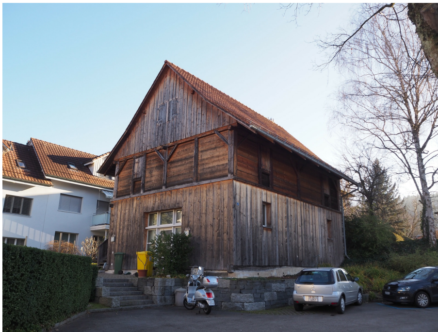
Ehem. Speicher- und Trottgebäude, Ansicht von NW, 07.12.2017 (Bild Nr. D101086_51).
