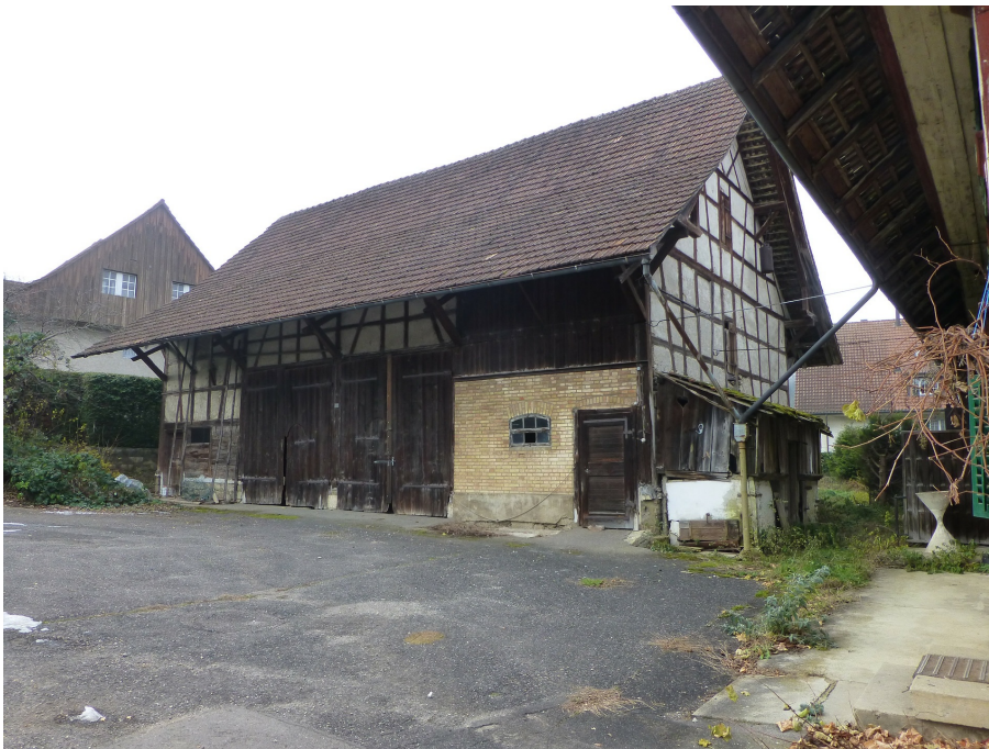
Sog. «Schellenberghaus» mit Doppelscheune, Doppelscheune (Vers. Nr. 00208, 00485), vor dem Umbau 2018, Ansicht von NO, 29.11.2013 (Bild Nr. D100552_56).
