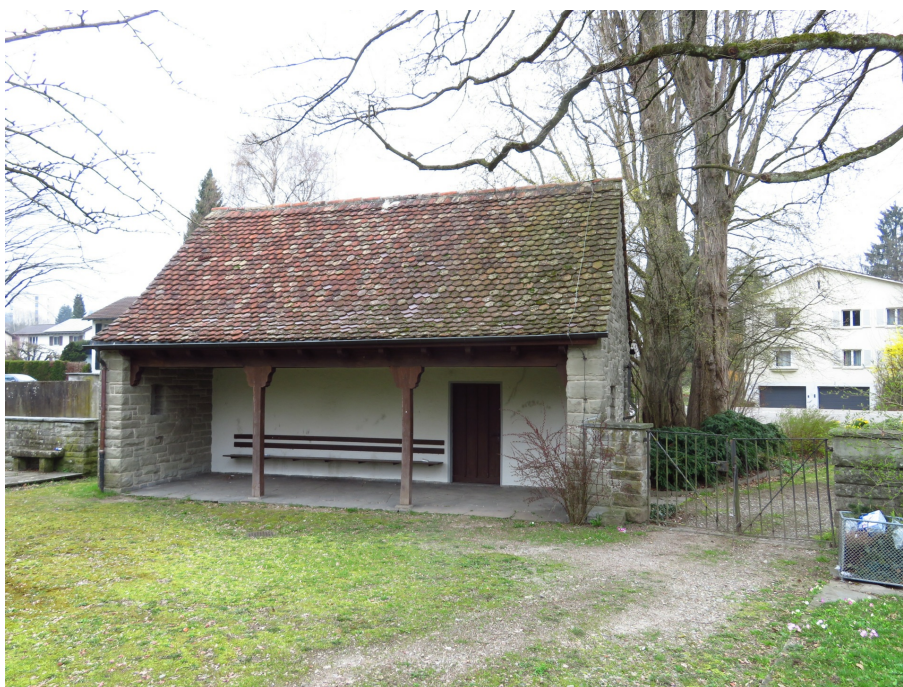
Friedhof Steinreben, Friedhofgebäude (Vers.-Nr. 00454), offene Halle mit Balkendecke und Holzstützen mit Zierschnitt, Ansicht von SO, 24.03.2017 (Bild Nr. D100586_04).
