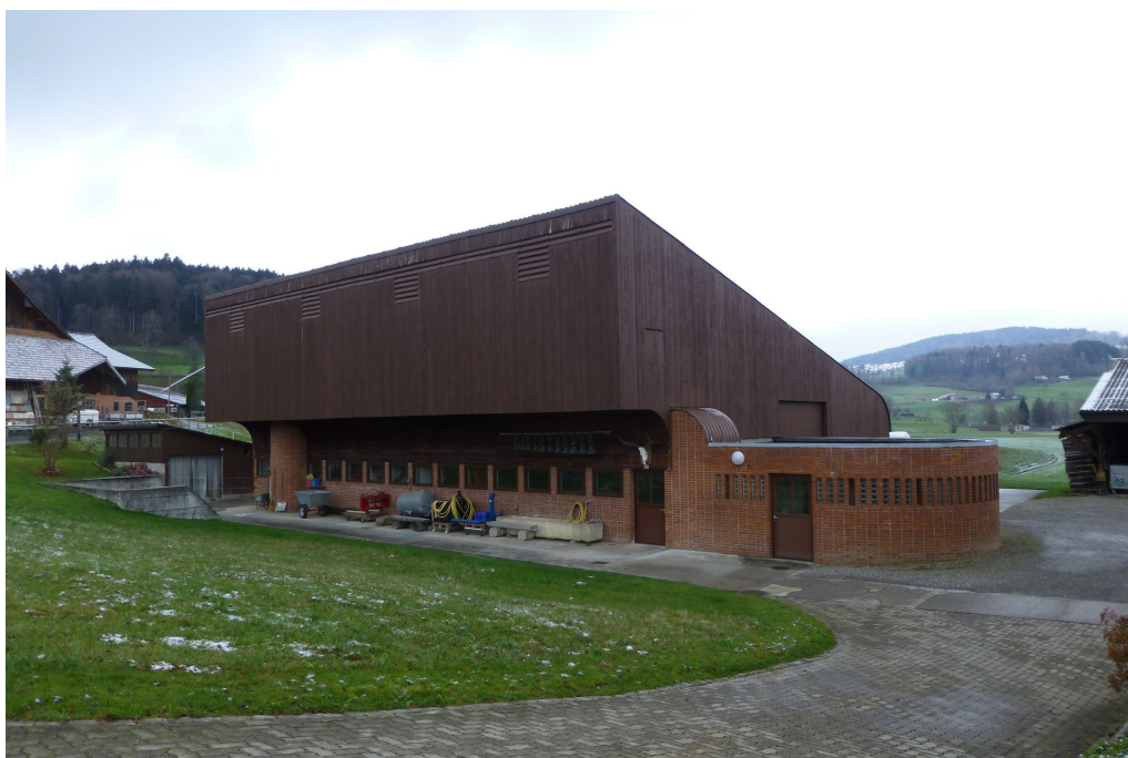
Jonenhof, Ökonomiegebäude (Vers. Nr. 00249) Ansicht von SO, 23.11.2015 (Bild Nr. D101061_13).
