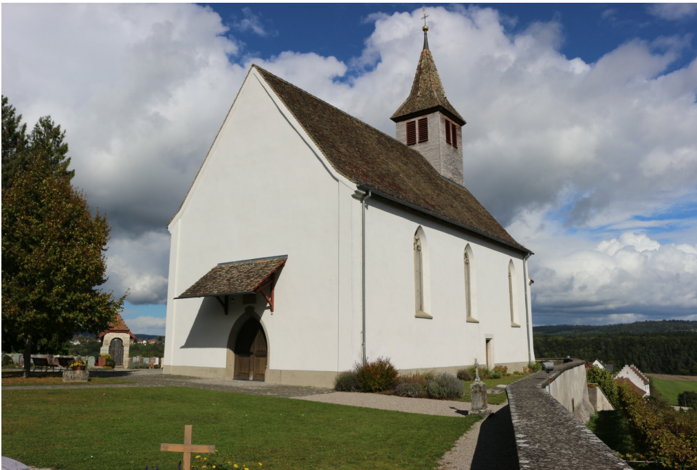
Kath. Bergkirche St. Nikolaus, Ansicht von SO, 06.10.2021 (Bild Nr. D101984_05).
