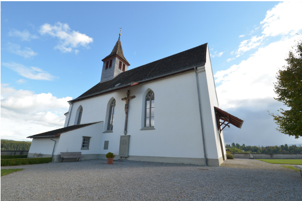
Kath. Bergkirche St. Nikolaus, Ansicht von NW, 06.10.2021 (Bild Nr. D101984_30).
