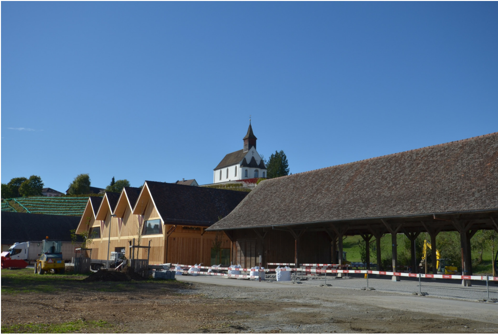
Kath. Bergkirche St. Nikolaus, Ansicht von SO, 06.10.2021 (Bild Nr. D101984_40).
