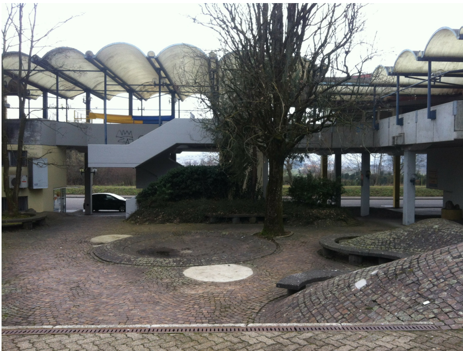
Wohnsiedlung «Sonnhalde», Zentrum (Vers. Nr. 01616, 01627, 01637), Ansicht von NO, Dorfplatz, ehemals Spielplatz und Standort «Lozziwurm», 04.02.2014 (Bild Nr. D100653_57).
