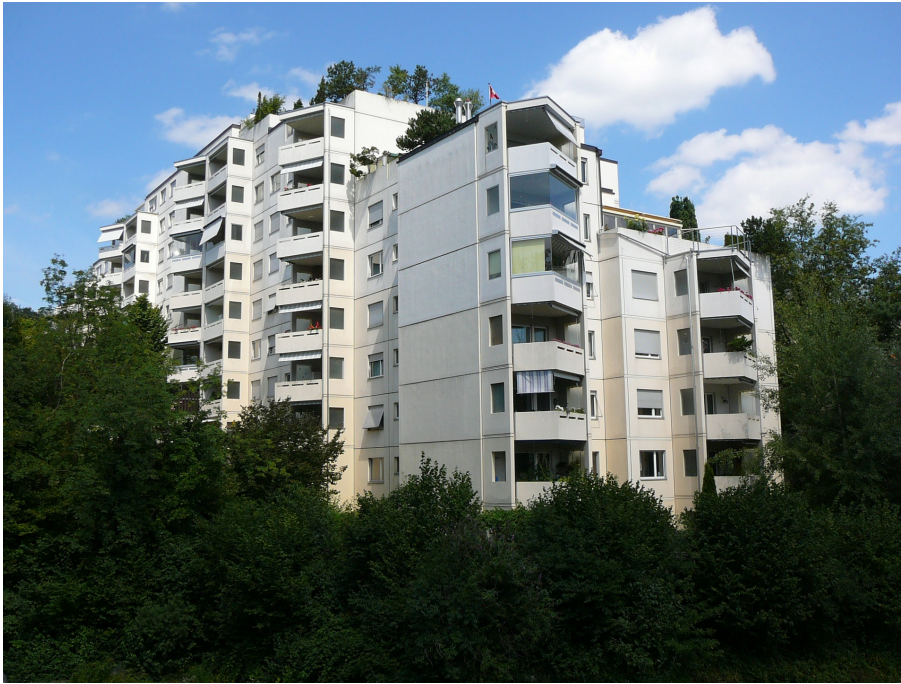
Wohnsiedlung «Sonnhalde», Mehrfamilienhaus (Vers. Nr. 01509), Ansicht von SW, 13.08.2013 (Bild Nr. D100651_23).
