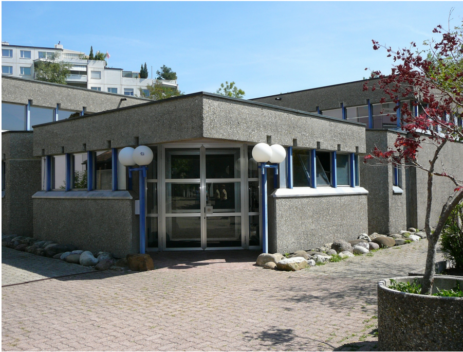
Wohnsiedlung «Sonnhalde», Verwaltungsgebäude (Vers. Nr. 01631), Ansicht von O, 22.08.2013 (Bild Nr. D100651_89).
