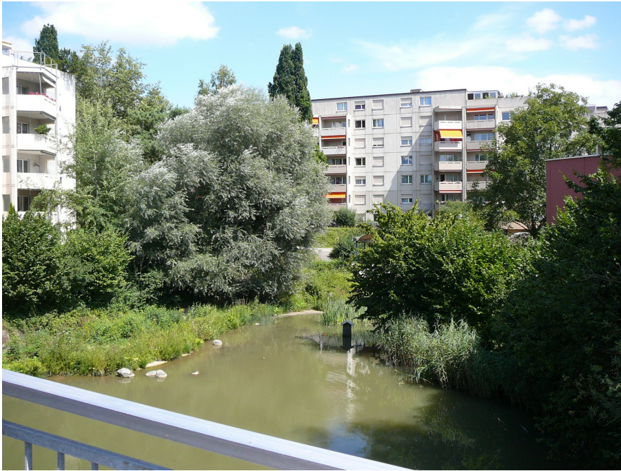
Wohnsiedlung «Sonnhalde», Mehrfamilienhaus (Vers. Nr. 01461), Ansicht von W, Dorfweiher, 13.08.2013 (Bild Nr. D100651_78).
