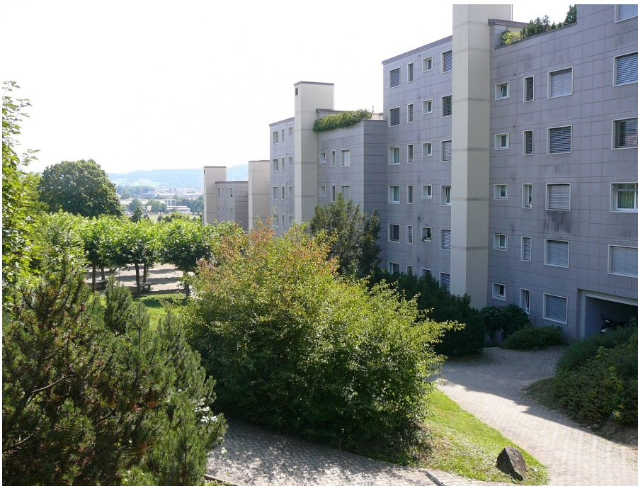
Wohnsiedlung «Sonnhalde», Mehrfamilienhaus (Vers. Nr. 01552), Ansicht von NO, 22.08.2013 (Bild Nr. D100651_56).
