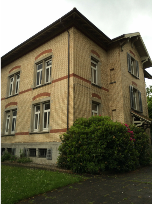
Direktions-, Dienstgebäude und Angestelltenwohnhäuser der Strafanstalt, Ansicht Direktorenhaus, Blick von N, 13.08.2013 (Bild Nr. D100663_24).
