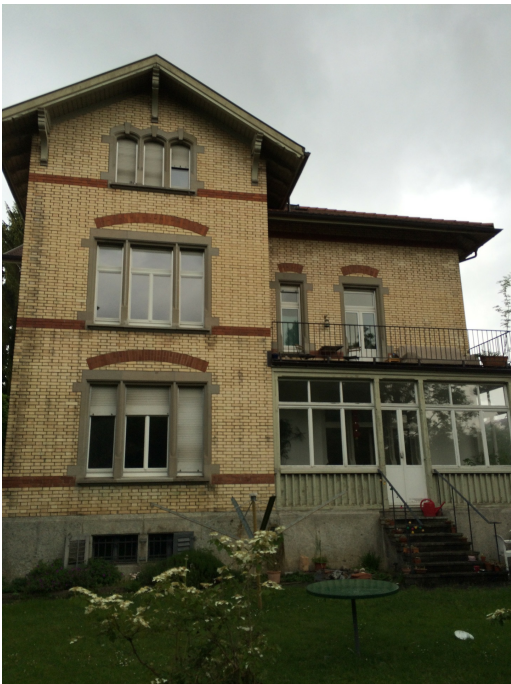
Direktions-, Dienstgebäude und Angestelltenwohnhäuser der Strafanstalt, Ansicht Direktorenhaus, Blick von O, 13.08.2013 (Bild Nr. D100663_25).
