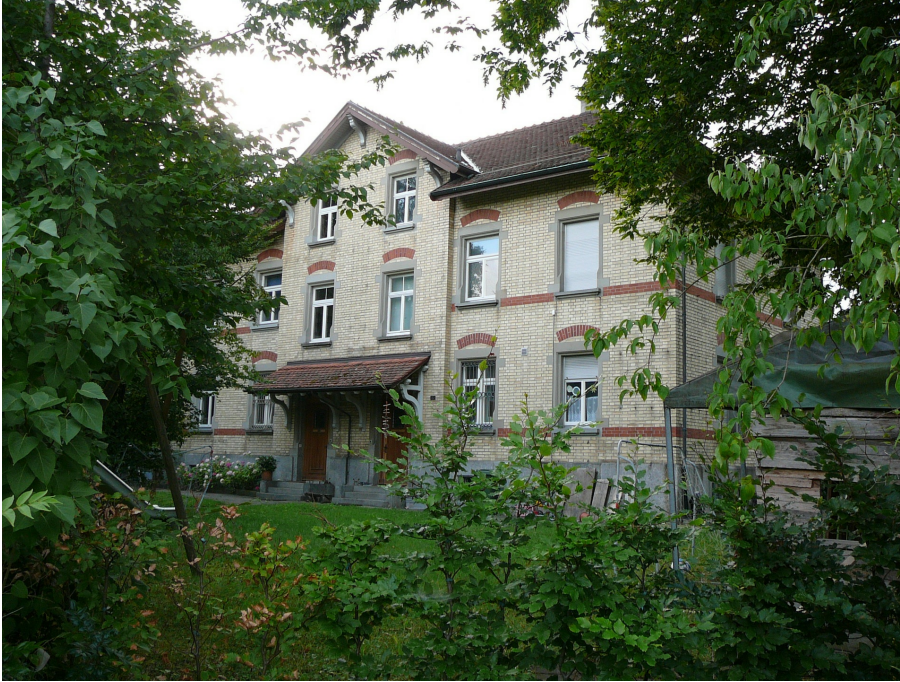
Direktions-, Dienstgebäude und Angestelltenwohnhäuser der Strafanstalt, Wohnhaus für Beamte (Vers. Nr. 00473), Ansicht von NW, 13.08.2013 (Bild Nr. D100654_22).
