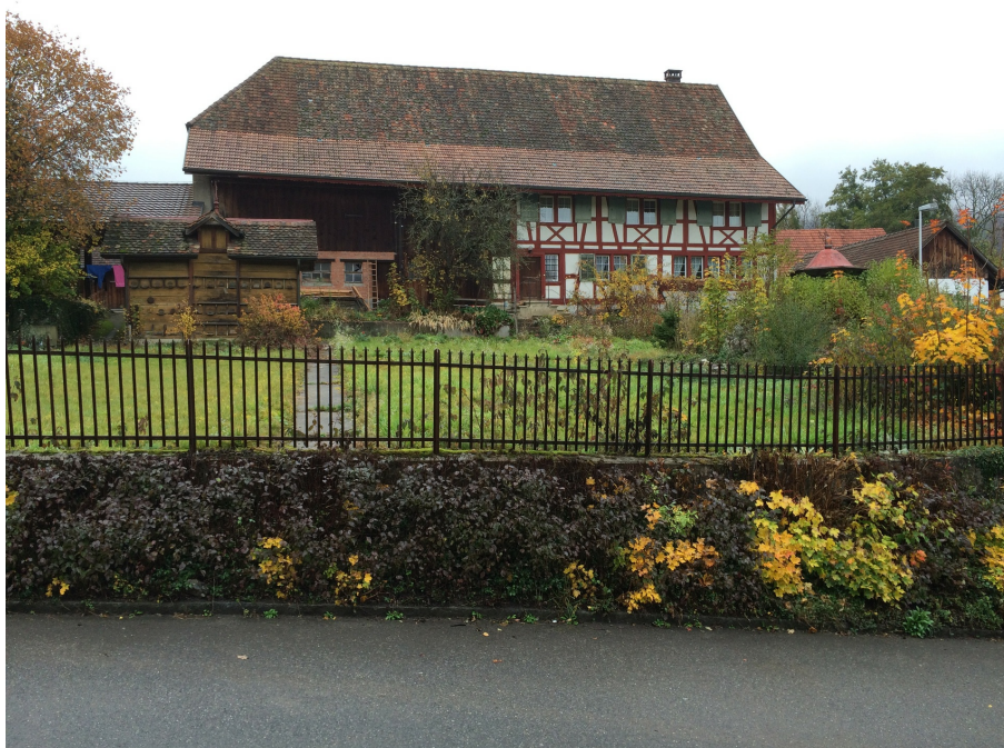
Bauernhaus mit Nebengebäuden und Garten, Bauernhaus (Vers. Nr. 00037, östl. Teil), Ansicht von S, 29.10.2015 (Bild Nr. D100663_12).
