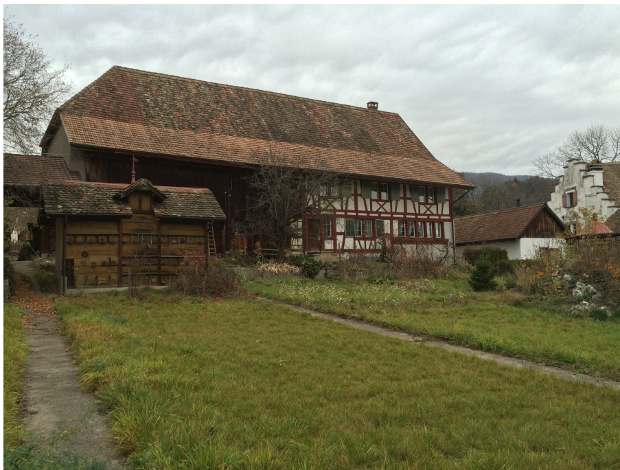
Bauernhaus mit Nebengebäuden und Garten, Bauernhaus (Vers. Nr. 00037, östl. Teil), Ansicht von S, 17.11.2015 (Bild Nr. D100664_36).
