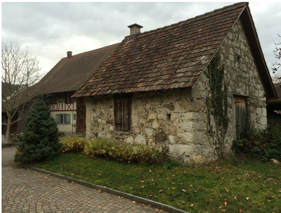
Bauernhaus mit Nebengebäuden und Garten, Waschhaus (Vers. Nr. 00039), Ansicht von NW, 17.11.2015 (Bild Nr. D100664_74).
