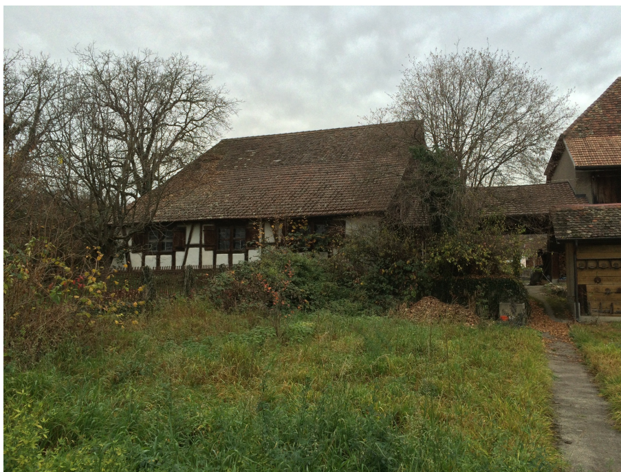
Bauernhaus mit Nebengebäuden und Garten, Speicher (Vers. Nr. 00037, westl. Teil), Ansicht von S, 17.11.2015 (Bild Nr. D100664_49).
