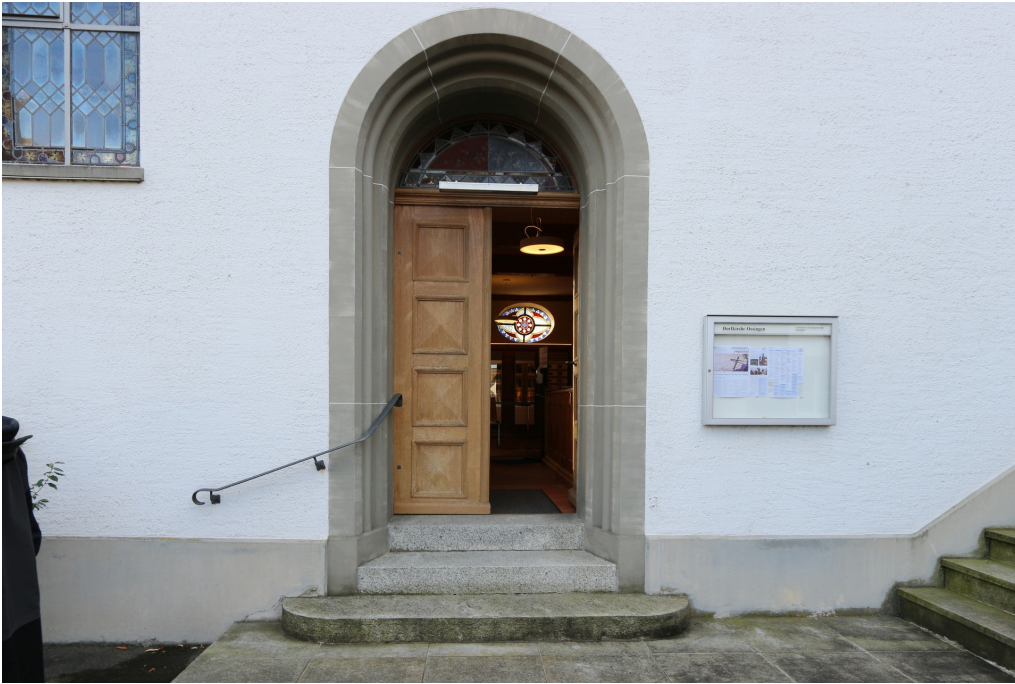
Ref. Kirche, Eingang, Ansicht von N, 06.10.2021 (Bild Nr. D101630_05).
