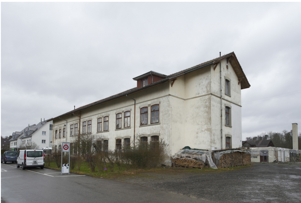
Ehem. Seidenweberei Stehli, ehem. Seidenweberei (Vers. Nr. 00260), Ansicht von NW, 01.02.2013 (Bild Nr. D100084_18).
