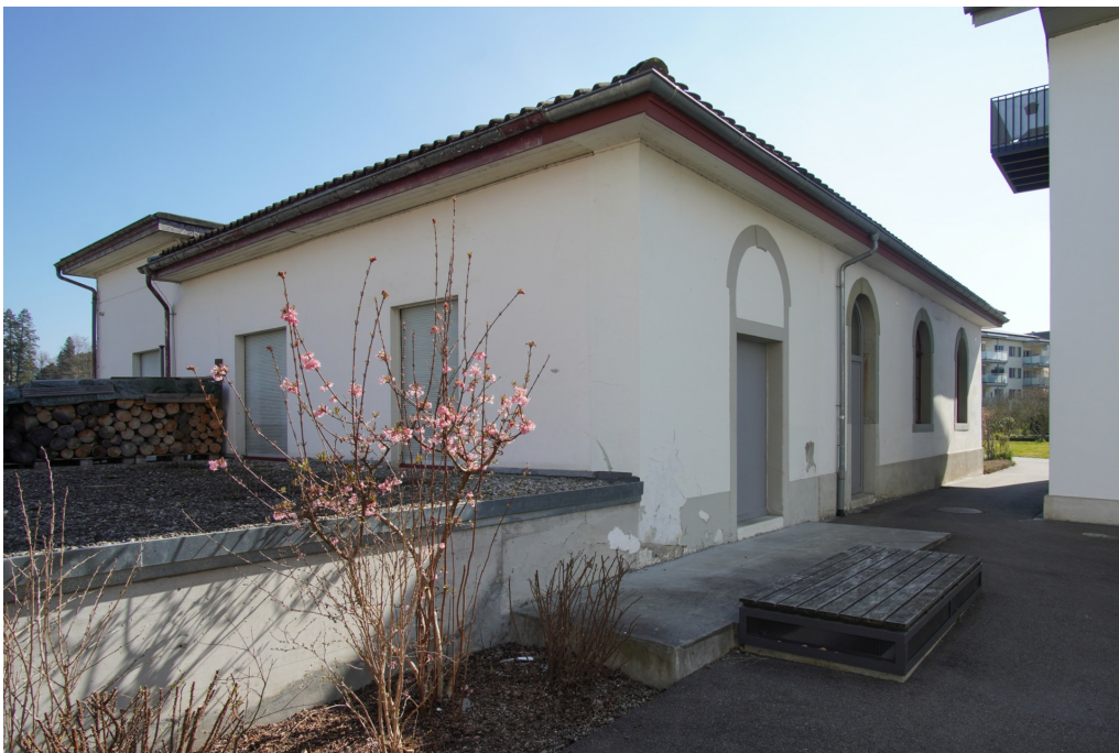
Ehem. Seidenweberei Stehli, ehem. Maschinen- und Dampfkesselhaus (Vers.-Nr. 01908), Ansicht von NW, 18.03.2025 (Bild Nr. D101647_33).
