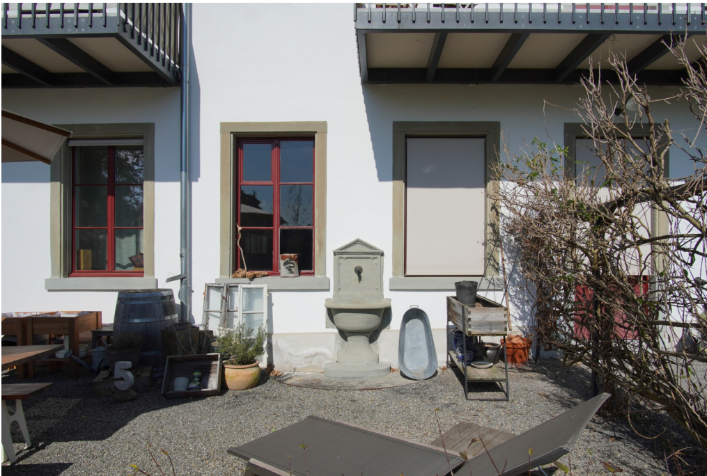
Ehem. Seidenweberei Stehli, ehem. Webereigebäude (Vers.-Nr. 00258), Wandbrunnen aus Sandstein, Ansicht von SO, 18.03.2025 (Bild Nr. D101647_19).
