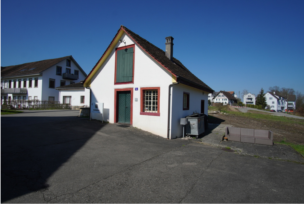
Ehem. Seidenweberei Stehli, ehem. Waschhaus (Vers.-Nr. 00251), Ansicht von SO, 18.03.2025 (Bild Nr. D101647_41).
