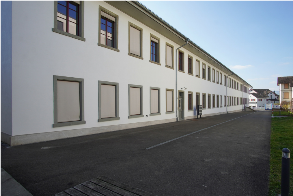
Ehem. Seidenweberei Stehli, ehem. Webereigebäude (Vers.-Nr. 00258), Ansicht von NO, 18.03.2025 (Bild Nr. D101647_22).
