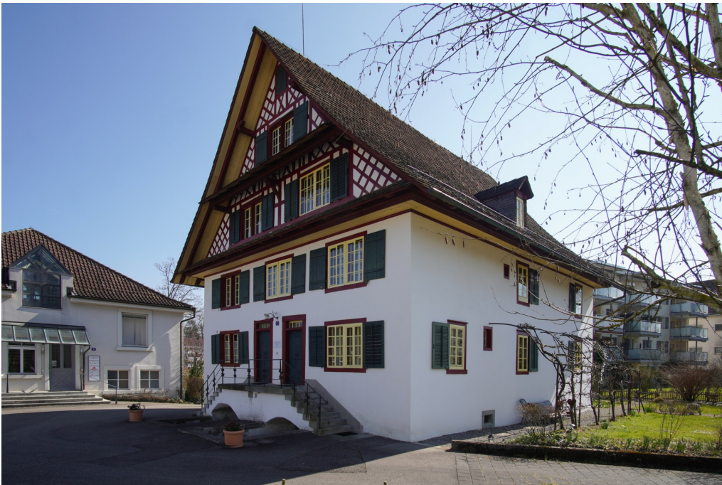
Ehem. Seidenweberei Stehli, ehem. Doppelbauernhaus (Vers.-Nr. 00255), Ansicht von NW, 18.03.2025 (Bild Nr. D101647_34).
