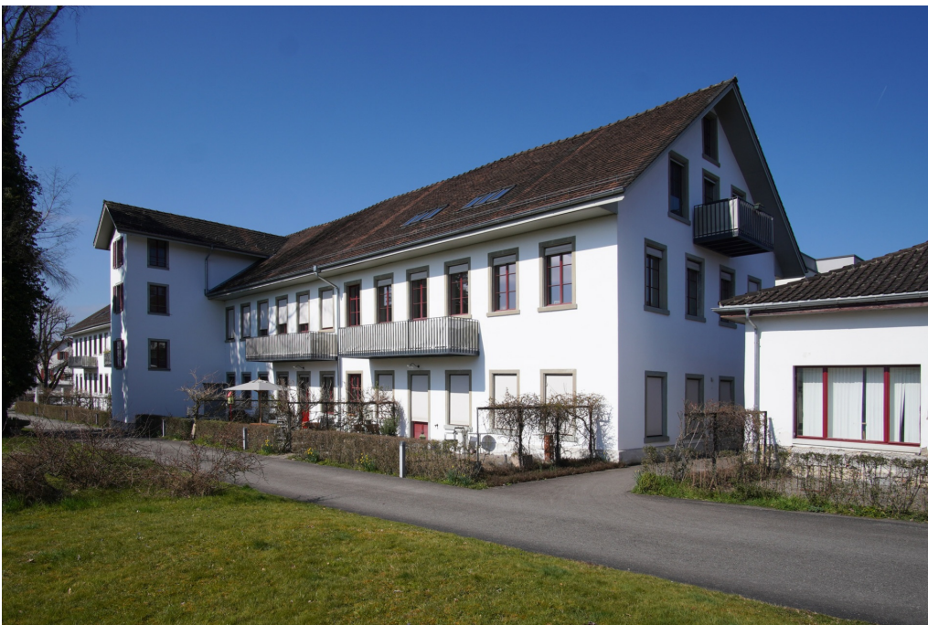
Ehem. Seidenweberei Stehli, ehem. Webereigebäude (Vers.-Nr. 00258), Ansicht von O, 18.03.2025 (Bild Nr. D101647_20).
