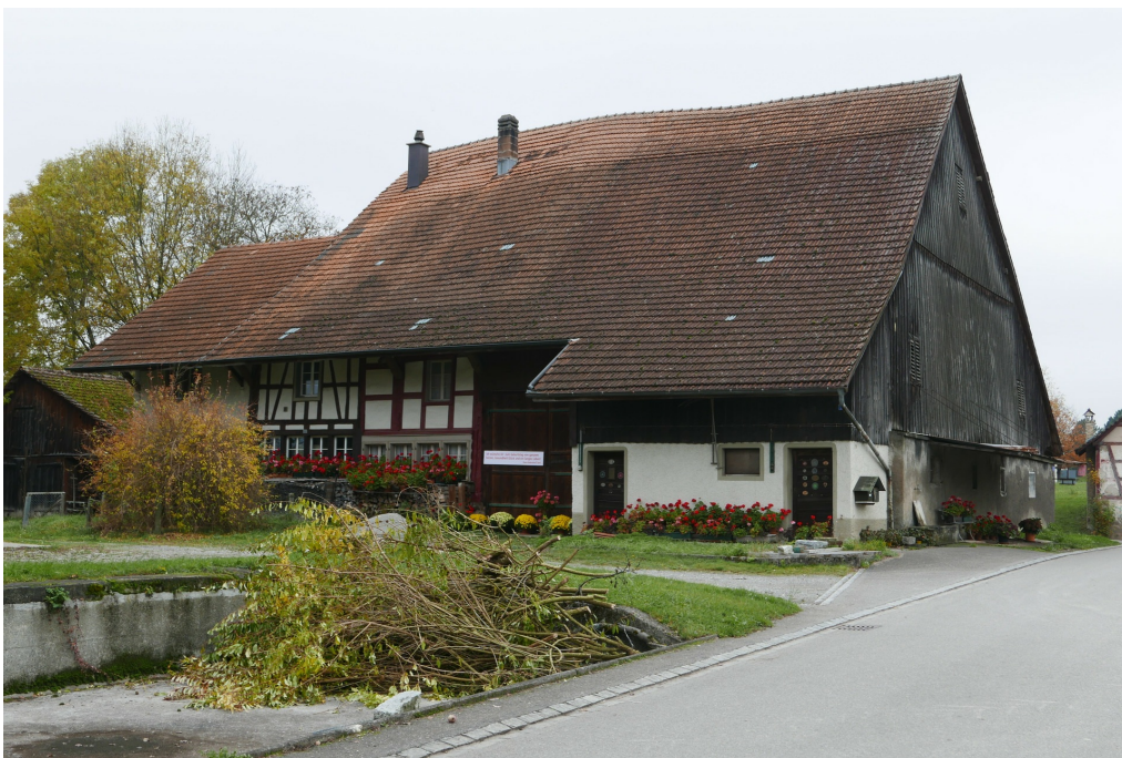
Vielzweckbauernhaus, Ansicht von SO, 31.10.2016 (Bild Nr. D100558_74).
