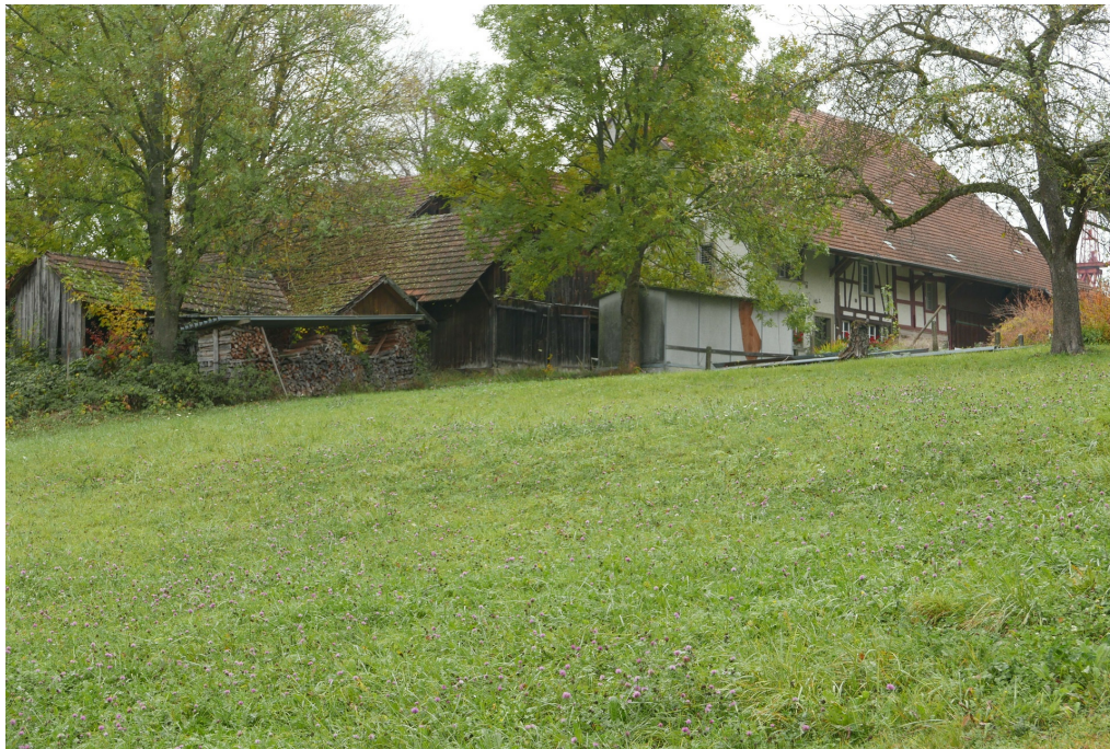
Vielzweckbauernhaus, Ansicht von SW, 31.10.2016 (Bild Nr. D100558_73).
