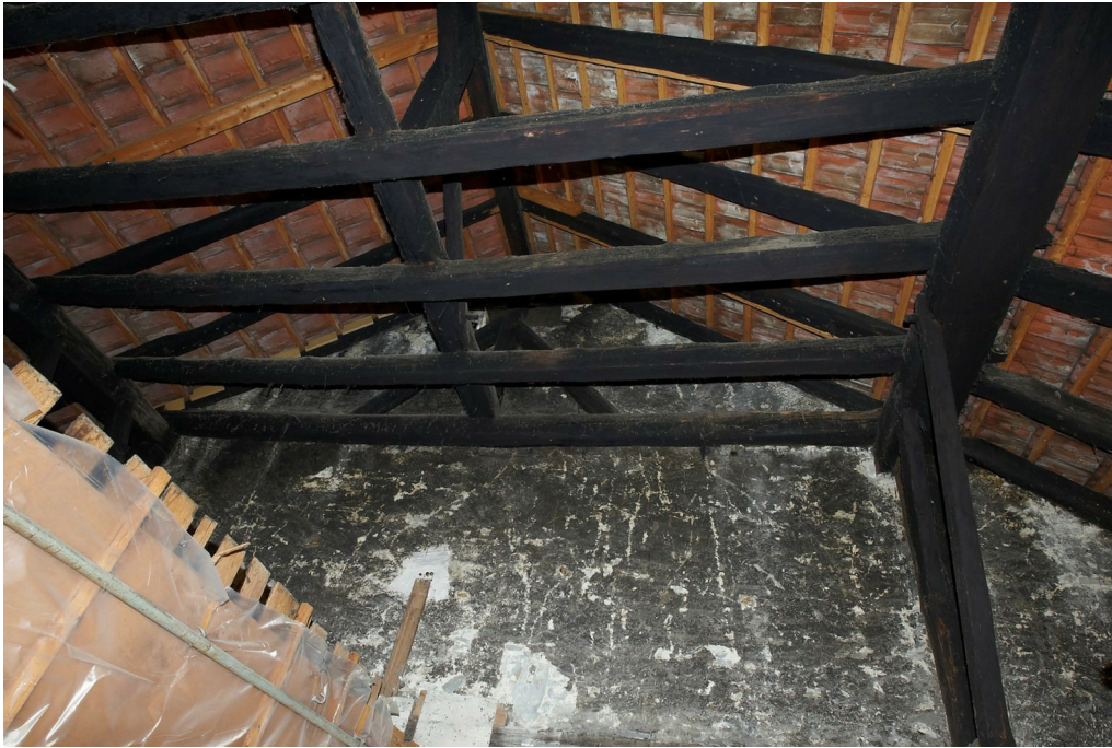
Ehem. Zehntenscheune, Hausteil NO (Vers. Nr. 01242), Wohnteil, rauchgeschwärzte Dachkonstruktion und Giebelwand, Ansicht von SO, 27.11.2015 (Bild Nr. D100587_41).
