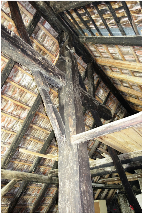
Ehem. Vielzweckbauernhaus, Wohnteil, Hochstud mit Windstrebe und gegen O verlängerter Firstpfette, Blick nach O, 16.11.2016 (Bild Nr. D100560_25).
