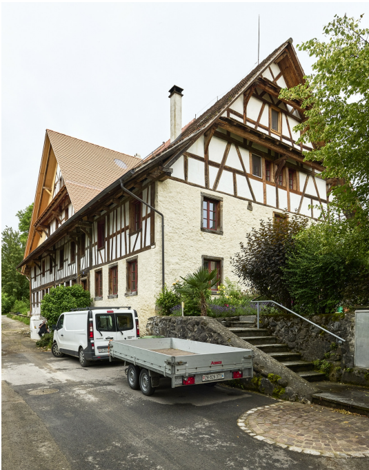
Ehem. Mühle Wissenbach mit Schweinestall, Quergiebelanbau (Vers. Nr. 00206), Ansicht von SW, 26.06.2024 (Bild Nr. D104776_24).
