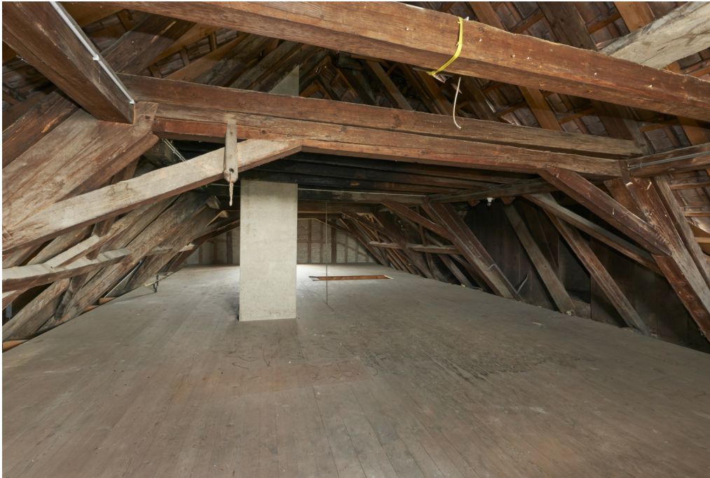
Ehem. Mühle Wissenbach mit Schweinestall, ehem. Mühlegebäude (Vers. Nr. 00207), Liegender Dachstuhl aus der M. des 17. Jh., 18.11.2021 (Bild Nr. D104110_90).
