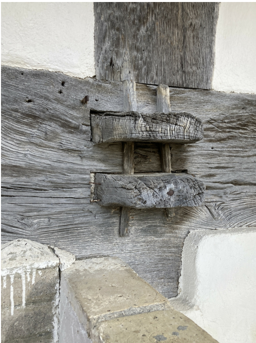
Ehem. Mühle Wissenbach mit Schweinestall, ehem. Mühlegebäude (Vers. Nr. 00207), Schwellenschloss an der Westfassade auf Höhe des Kellereingangs, 23.02.2022 (Bild Nr. D100691_29).
