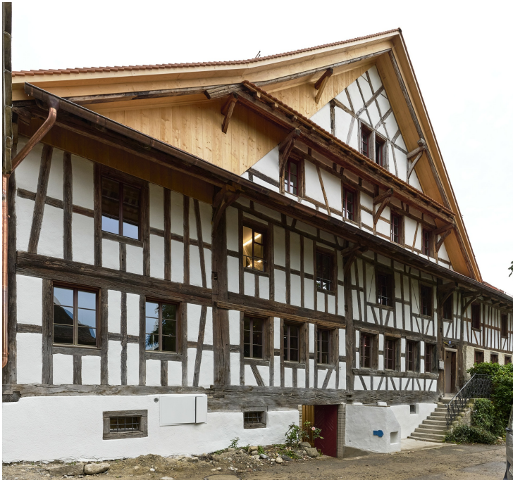
Ehem. Mühle Wissenbach mit Schweinestall, ehem. Mühlegebäude (Vers. Nr. 00207), Ansicht von NW, 26.06.2024 (Bild Nr. D104776_15).
