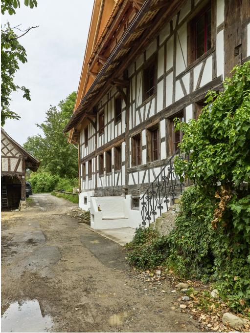
Ehem. Mühle Wissenbach mit Schweinestall, ehem. Mühlegebäude (Vers. Nr. 00207), Ansicht von SW, 26.06.2024 (Bild Nr. D104776_26).
