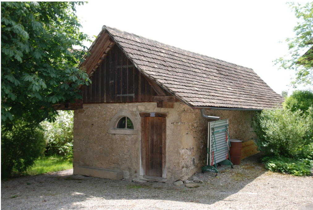
Ehem. Mühle Wissenbach mit Schweinestall, Ansicht von NO, 31.05.2012 (Bild Nr. D100065_51).
