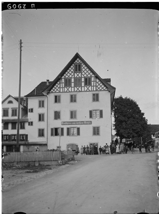
Gasthaus «zum weissen Rössli», Ansicht von W, links Hausteil D, ganz links Vorgängerbau von Hausteil E, 01.01.1914 (Bild Nr. U02909).
