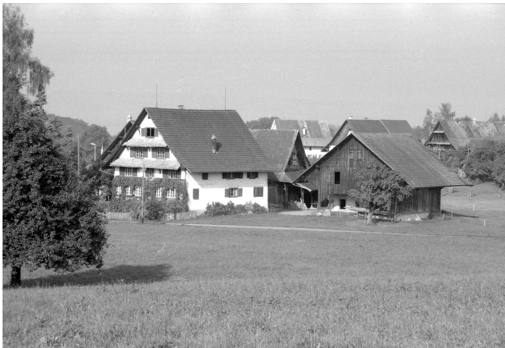
Hof Rossau, Doppelbauernwohnhaus (Vers. Nr. 00131) und Pferdestall (Vers. Nr. 00181), Ansicht von NO, 06.09.1996 (Bild Nr. L23178_09).
