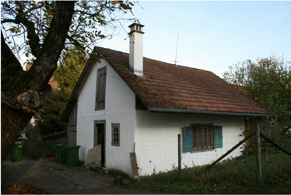
Hof Rossau, Waschhaus (Vers. Nr. 00130), Ansicht von W, 03.11.2016 (Bild Nr. D101063_71).
