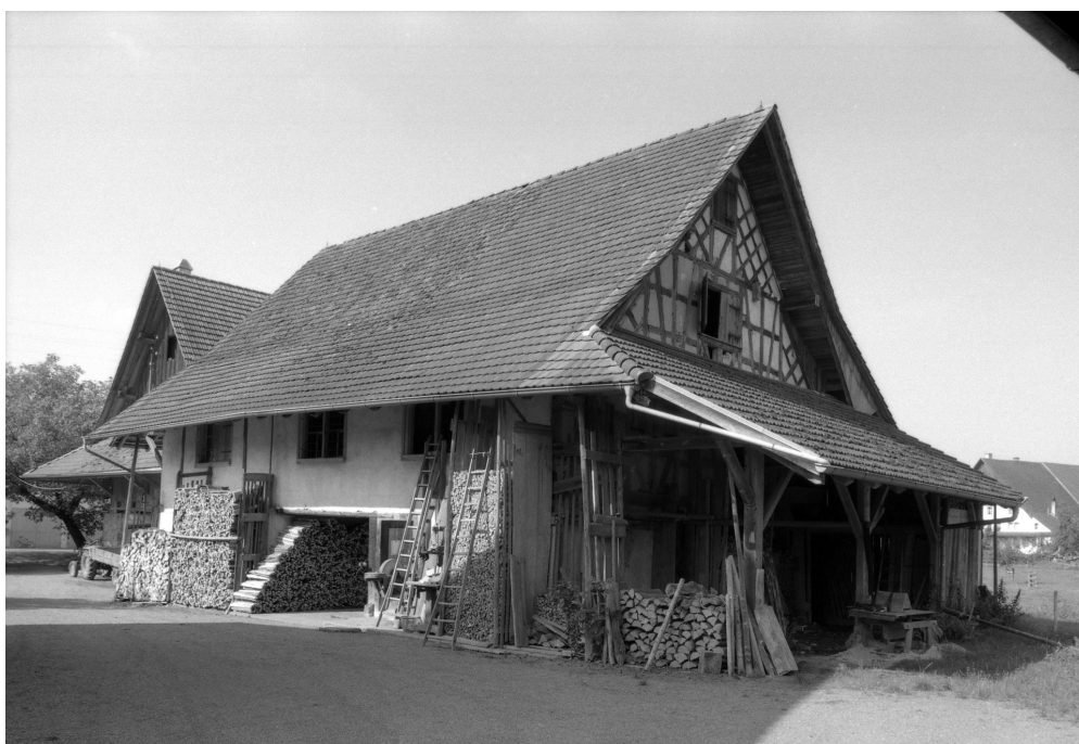
Hof Rossau, Trotte mit Holzschopf (Vers. Nr. 00132), Ansicht von NO, 06.09.1996 (Bild Nr. L23178_11).
