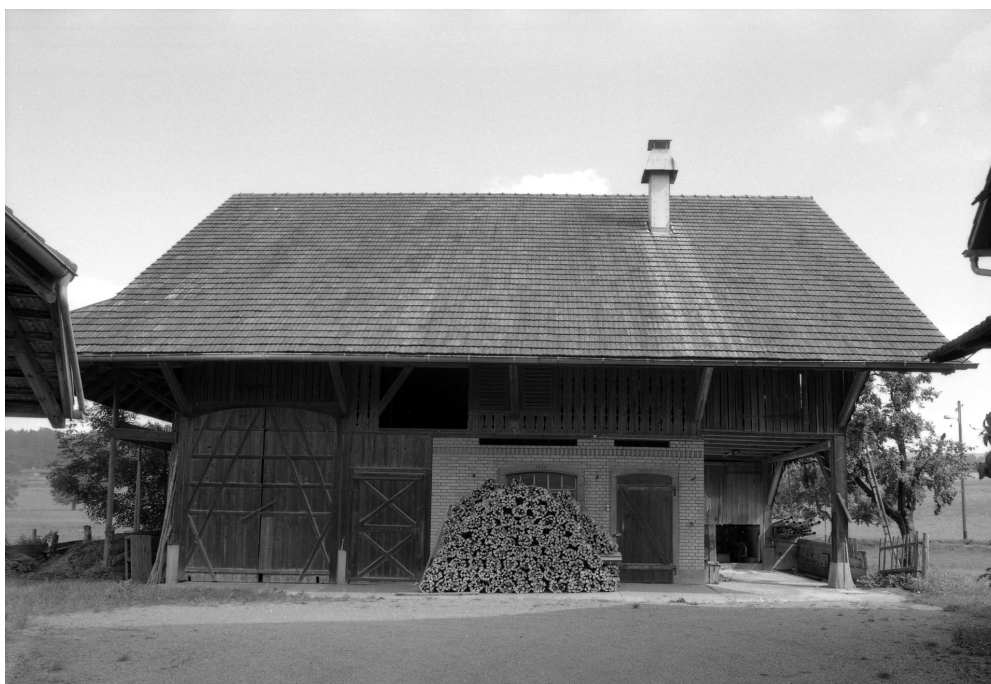
Hof Rossau, Pferdestall (Vers. Nr. 00181), Ansicht von SW, 06.09.1996 (Bild Nr. L23178_15).
