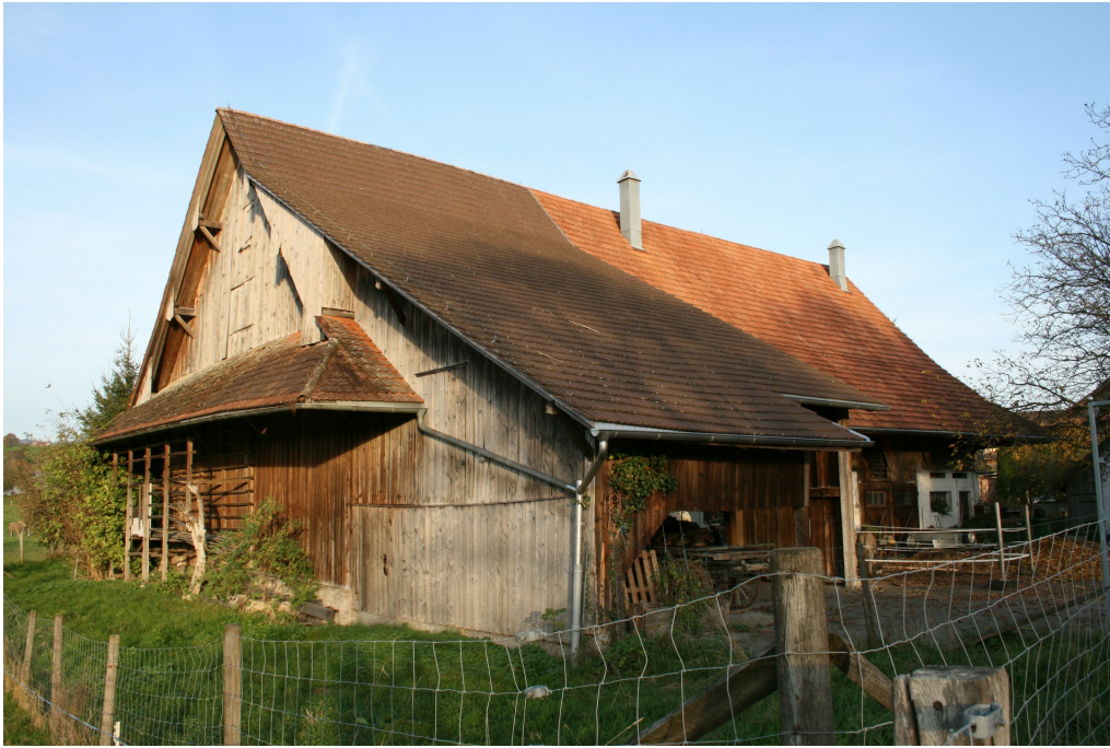
Hof Rossau, Stallscheune (Vers. Nr. 00133), Ansicht von W, 03.11.2016 (Bild Nr. D101063_72).
