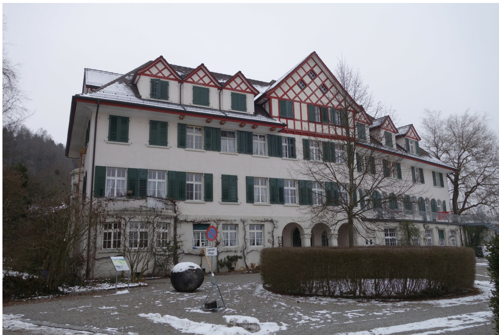
Werk- und Wohnhaus zur Weid, Ansicht von SW, 25.01.2017 (Bild Nr. D101063_69).
