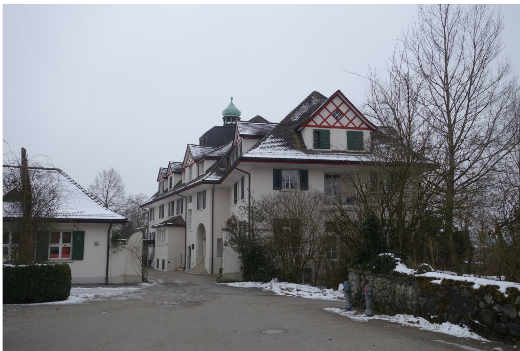
Werk- und Wohnhaus zur Weid, Ansicht von NW, 25.01.2017 (Bild Nr. D101063_68).
