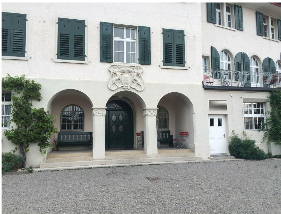
Werk- und Wohnhaus zur Weid, Eingang S, Ansicht von S, 26.09.2016 (Bild Nr. D101063_65).
