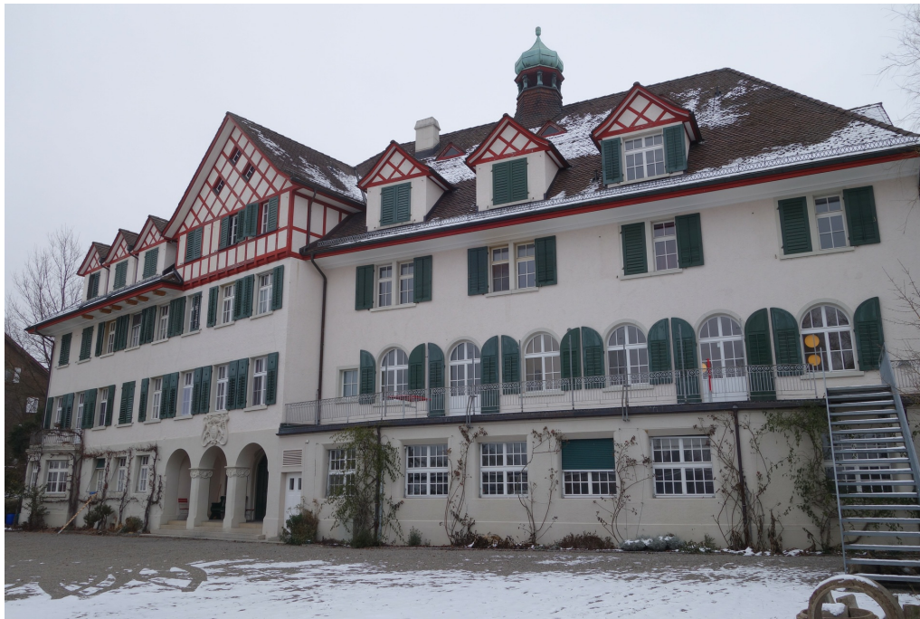
Werk- und Wohnhaus zur Weid, Ansicht von S, 25.01.2017 (Bild Nr. D101063_66).
