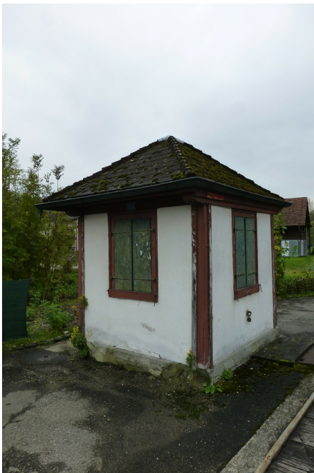
Brückenwaage, Ansicht von O, 15.10.2015 (Bild Nr. D101076_52).
