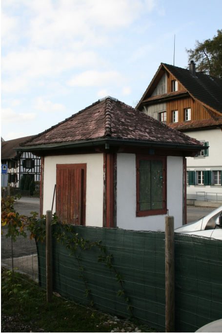
Brückenwaage, Ansicht von SO, 04.11.2016 (Bild Nr. D101076_53).
