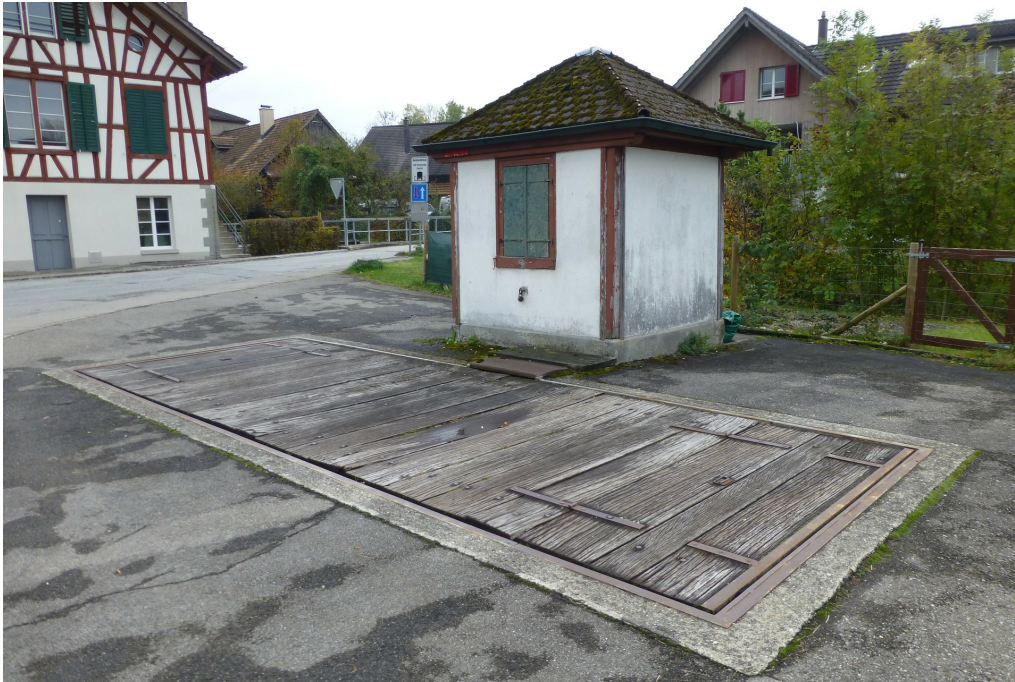
Brückenwaage, Ansicht von NW, 15.10.2015 (Bild Nr. D101076_51).
