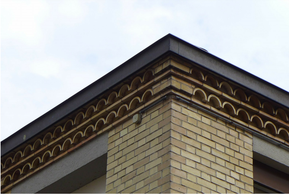
«Maggi-Areal», Betriebsbauten, Bürogebäude (Vers. Nr. 01204), Kranzgesims der Nordwestecke (Detail), 29.08.2016 (Bild Nr. D101150_18).
