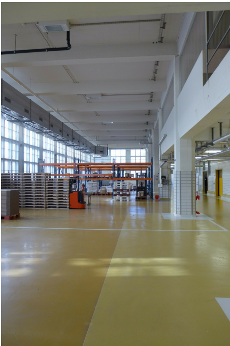
«Maggi-Areal», Betriebsbauten, Bouillonfabrik (Vers. Nr. 01244), Fabriksaal, Blick Richtung N, 29.08.2016 (Bild Nr. D101150_51).
