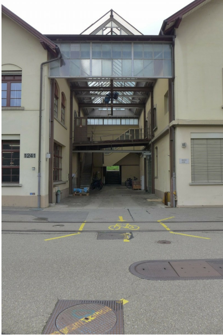
«Maggi-Areal», Betriebsbauten, Werkstattgebäude (Vers. Nr. 01240), überdachter Zwischenbereich zwischen dem Nord- und dem Mitteltrakt, Ansicht von O, 29.08.2016 (Bild Nr. D101150_47).
