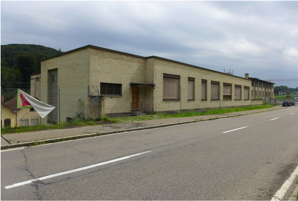
«Maggi-Areal», Betriebsbauten, Laborgebäude (Vers. Nr. 01261), Ansicht von NW, 29.08.2016 (Bild Nr. D101150_55).
