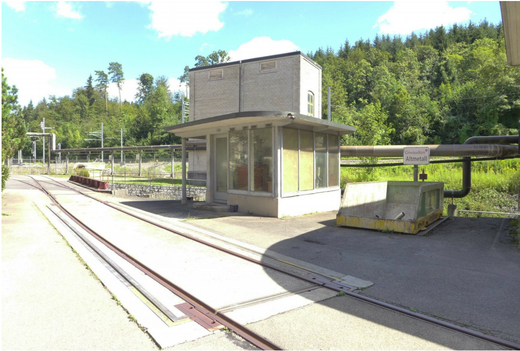
«Maggi-Areal», Betriebsbauten, Waaghaus (Vers. Nr. 01206) und Waage (176WAAGE01206), Ansicht von SW, 29.08.2016 (Bild Nr. D101150_23).
