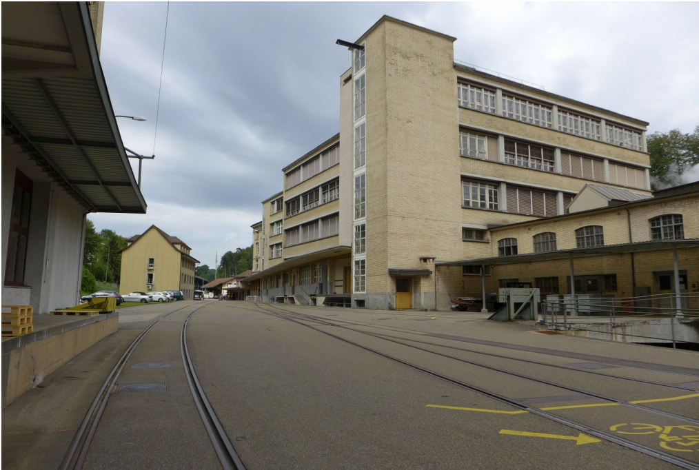
«Maggi-Areal», Betriebsbauten, Magazingebäude, Spedition und Portierhaus (Vers. Nr. 01202); Spedition, Ansicht von SW; rechts das Kesselhaus (Vers. Nr. 01203), 29.08.2016 (Bild Nr. D101150_03).
