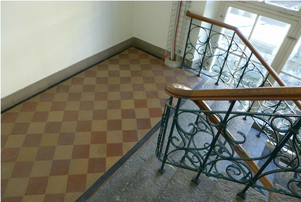
«Maggi-Areal», Betriebsbauten, Maschinen- und Lagerhaus, Kesselhaus mit Hochkamin, Speisesaalanbau und Lokremise (Vers. Nr. 01203); Treppenhaus im Maschinen- und Lagerhaus, 29.08.2016 (Bild Nr. D101150_12).
