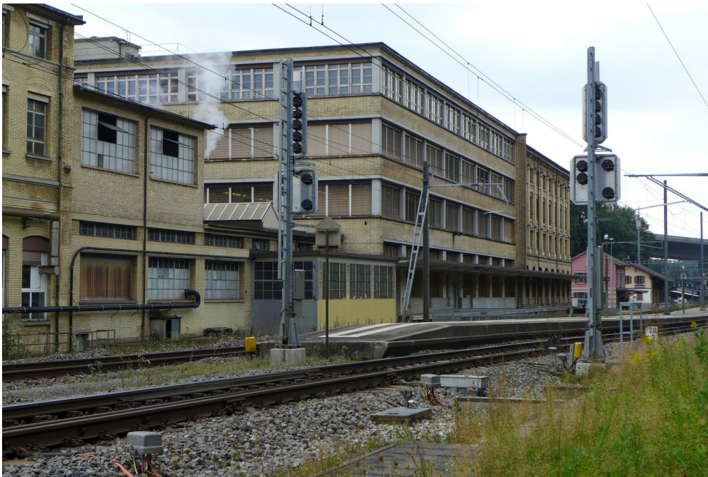
«Maggi-Areal», Betriebsbauten, Magazingebäude, Spedition und Portierhaus, (Vers. Nr. 01202); Spedition (Bildmitte), Ansicht von SO; ganz links das Kesselhaus (Vers. Nr. 01203), 29.08.2016 (Bild Nr. D101150_02).
