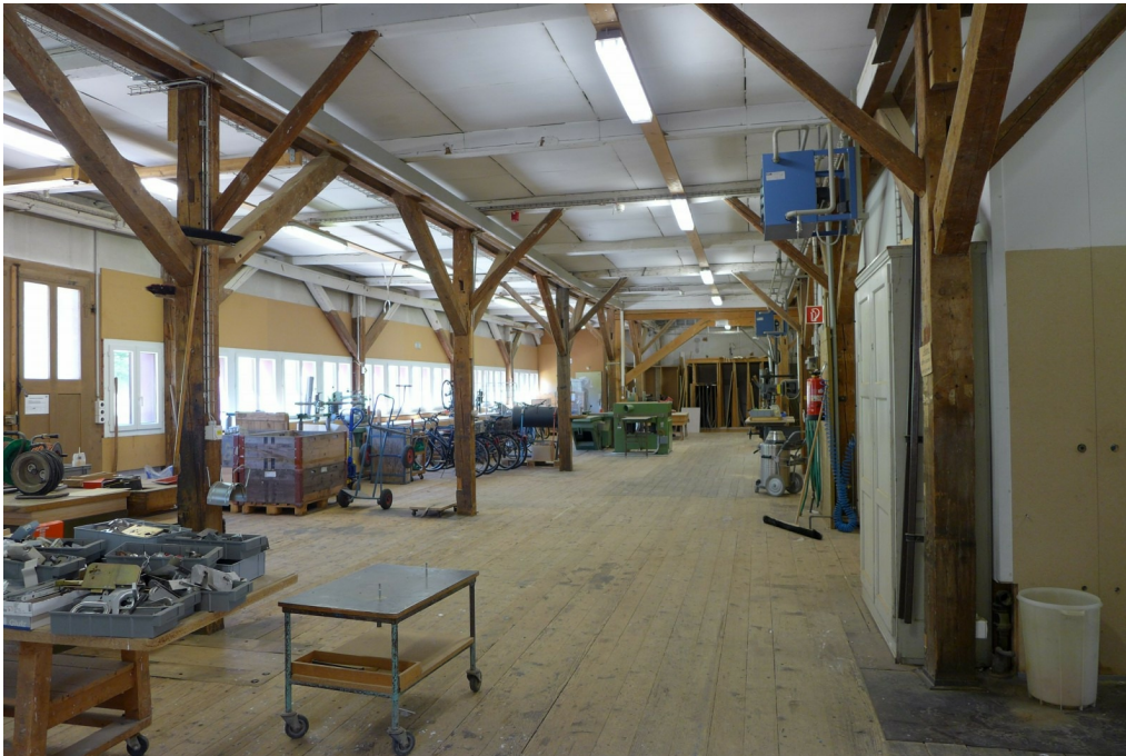
«Maggi-Areal», Betriebsbauten, Werkstattgebäude (Vers. Nr. 01240), Werkstatt im OG des Nordtrakts, Blick Richtung N, 29.08.2016 (Bild Nr. D101150_48).
