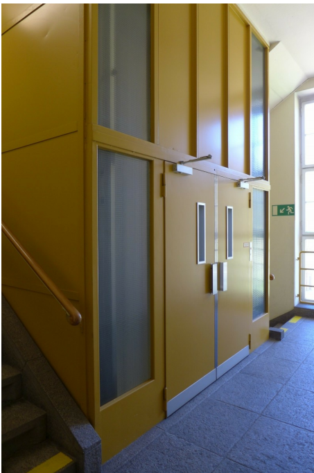
«Maggi-Areal», Betriebsbauten, Magazingebäude, Spedition und Portierhaus (Vers. Nr. 01202); Aufzug in der Spedition, 29.08.2016 (Bild Nr. D101150_04).
