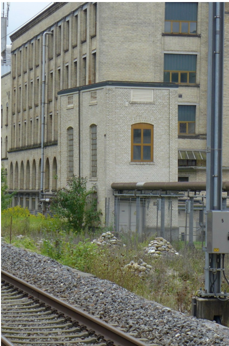
«Maggi-Areal», Betriebsbauten, Transformatorstation (Vers. Nr. 01205), Ansicht von NO, 29.08.2016 (Bild Nr. D101150_20).
