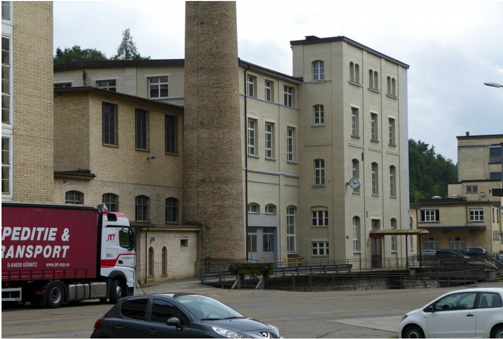
«Maggi-Areal», Betriebsbauten, Maschinen- und Lagerhaus, Kesselhaus mit Hochkamin, Speisesaalanbau und Lokremise (Vers. Nr. 01203); Maschinenhaus, Ansicht von NW; links davor das Kesselhaus (Vers. Nr. 01203) mit Hochkamin, 29.08.2016 (Bild Nr. D101150_09).
