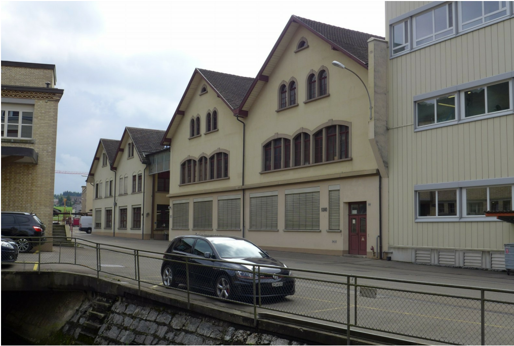
«Maggi-Areal», Betriebsbauten, Werkstattgebäude (Vers. Nr. 01240), Ansicht von NO, 29.08.2016 (Bild Nr. D101150_45).
