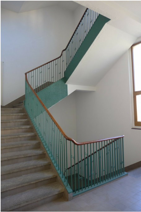
«Maggi-Areal», Betriebsbauten, Würzefabrik mit Garagenanbau/Feuerwehrdepot (Vers. Nr. 01208); Würzefabrik, südliches Treppenhaus, 29.08.2016 (Bild Nr. D101150_30).
