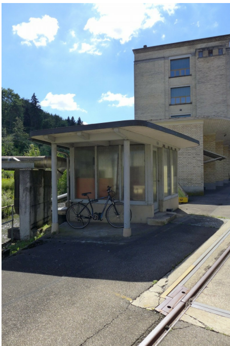
«Maggi-Areal», Betriebsbauten, Waaghaus (Vers. Nr. 01206), Ansicht von NW, 29.08.2016 (Bild Nr. D101150_24).
