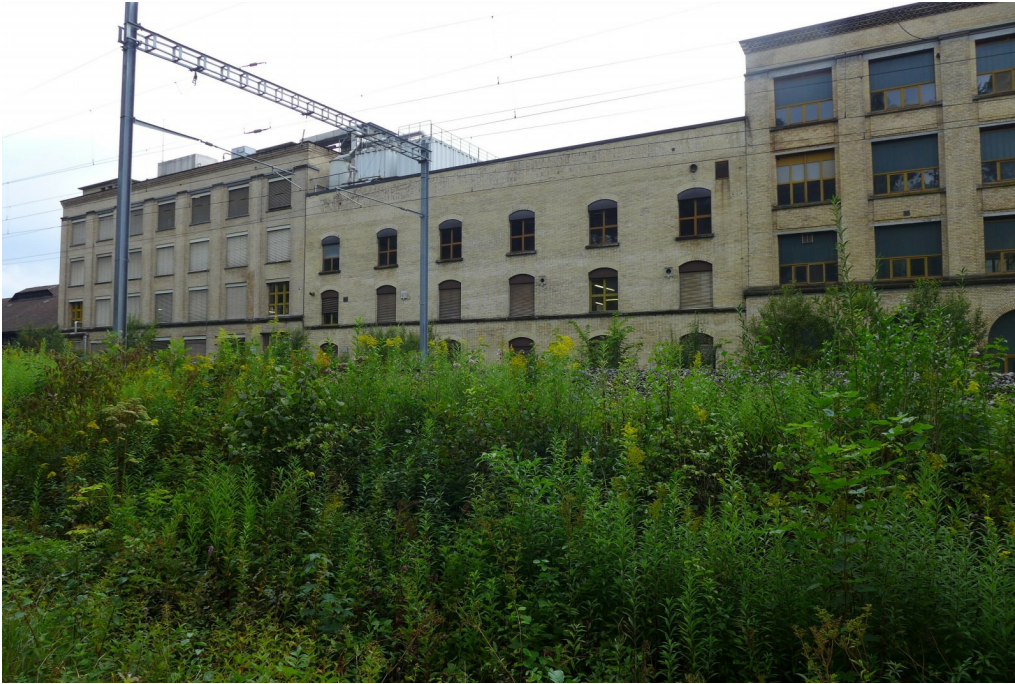
«Maggi-Areal», Betriebsbauten, Magazin- und Fabrikgebäude (Vers. Nr. 01210), Ansicht von O, 29.08.2016 (Bild Nr. D101150_36).
