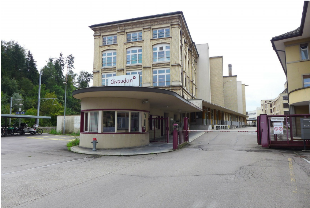
«Maggi-Areal», Betriebsbauten, Magazingebäude, Spedition und Portierhaus (Vers. Nr. 01202); im Vordergrund das Portierhaus, dahinter das Magazingebäude, Ansicht von N, 29.08.2016 (Bild Nr. D101150_05).
