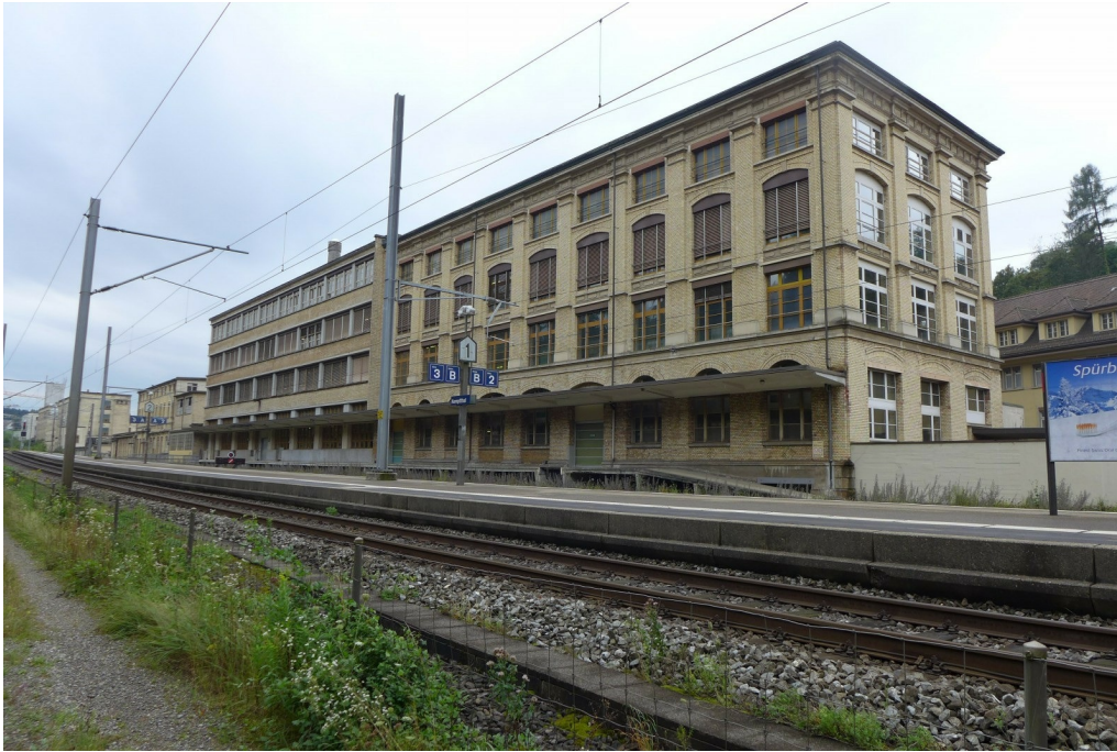
«Maggi-Areal», Betriebsbauten, Magazingebäude, Spedition und Portierhaus (Vers. Nr. 01202); Spedition (links) und Magazingebäude, Ansicht von NO, 29.08.2016 (Bild Nr. D101150_01).
