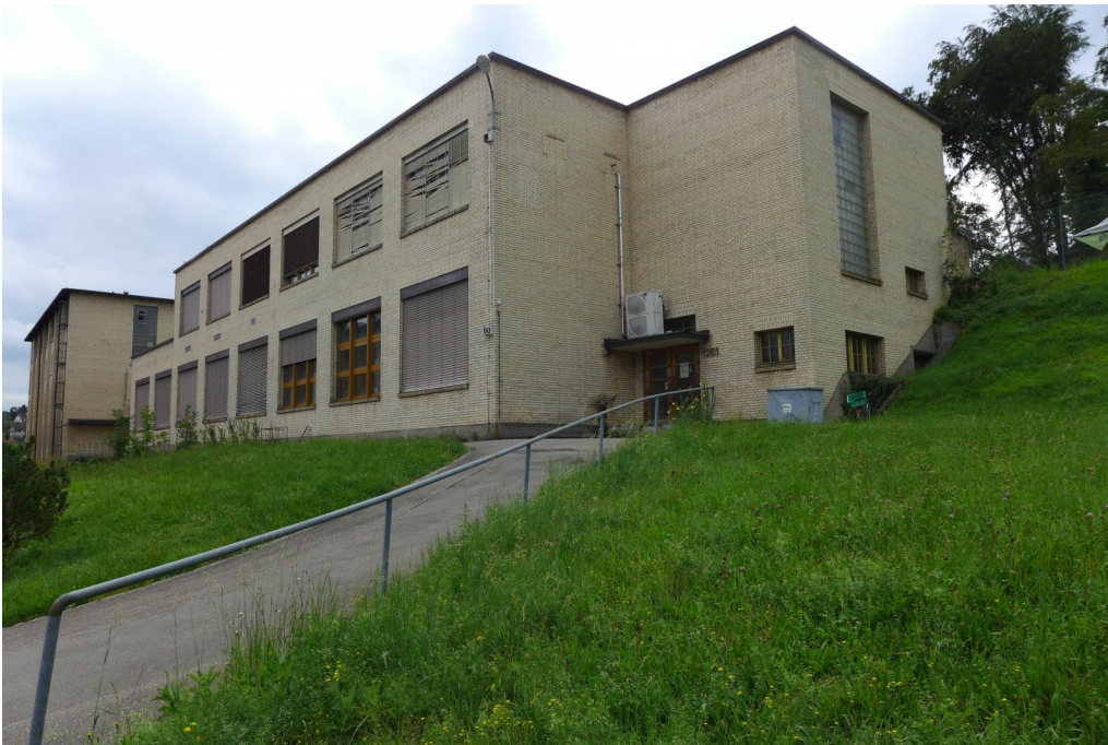
«Maggi-Areal», Betriebsbauten, Laborgebäude (Vers. Nr. 01261), Ansicht von NO, 29.08.2016 (Bild Nr. D101150_54).
