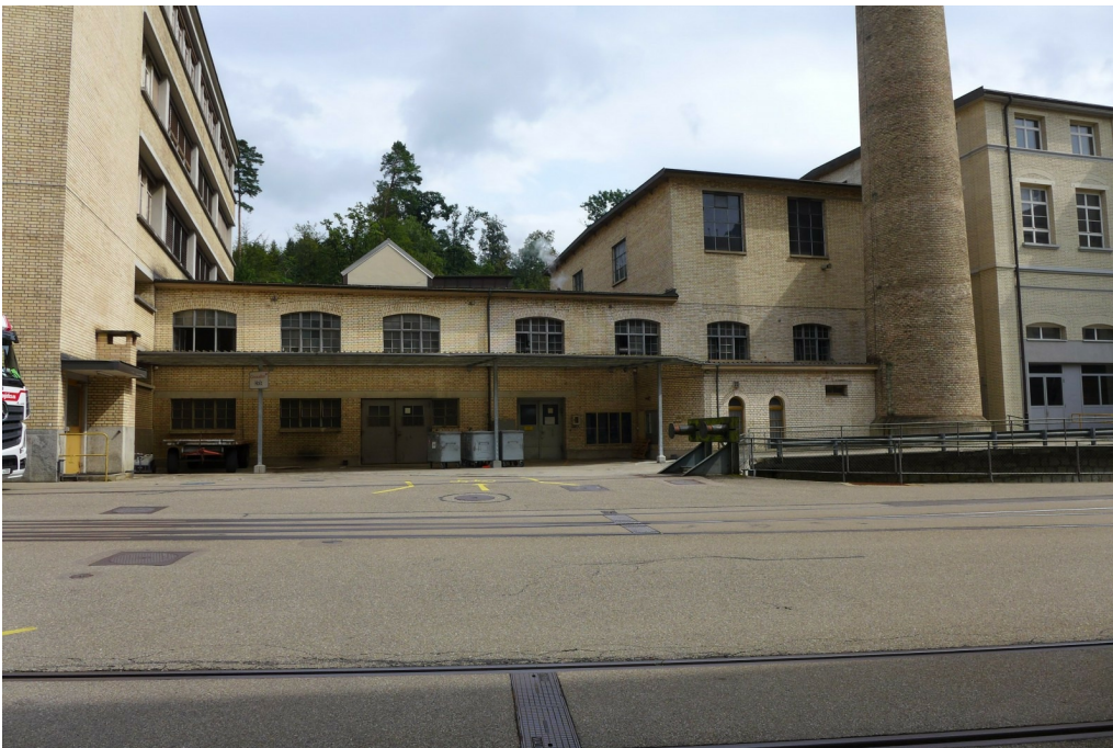
«Maggi-Areal», Betriebsbauten, Maschinen- und Lagerhaus, Kesselhaus mit Hochkamin, Speisesaalanbau und Lokremise (Vers. Nr. 01203); Kesselhaus mit Hochkamin, Ansicht von W, 29.08.2016 (Bild Nr. D101150_13).
