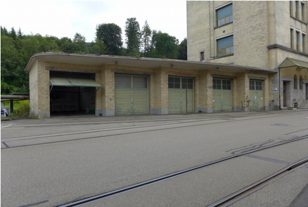
«Maggi-Areal», Betriebsbauten, Würzefabrik mit Garagenanbau/Feuerwehrdepot (Vers. Nr. 01208); Garagenanbau/Feuerwehrdepot, Ansicht von NW, 29.08.2016 (Bild Nr. D101150_33).
