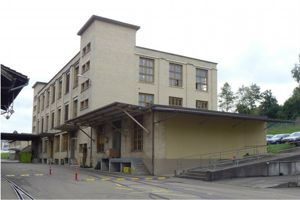
«Maggi-Areal», Betriebsbauten, Kistennaglerei (Vers. Nr. 01246), Ansicht von NO, 29.08.2016 (Bild Nr. D101150_53).
