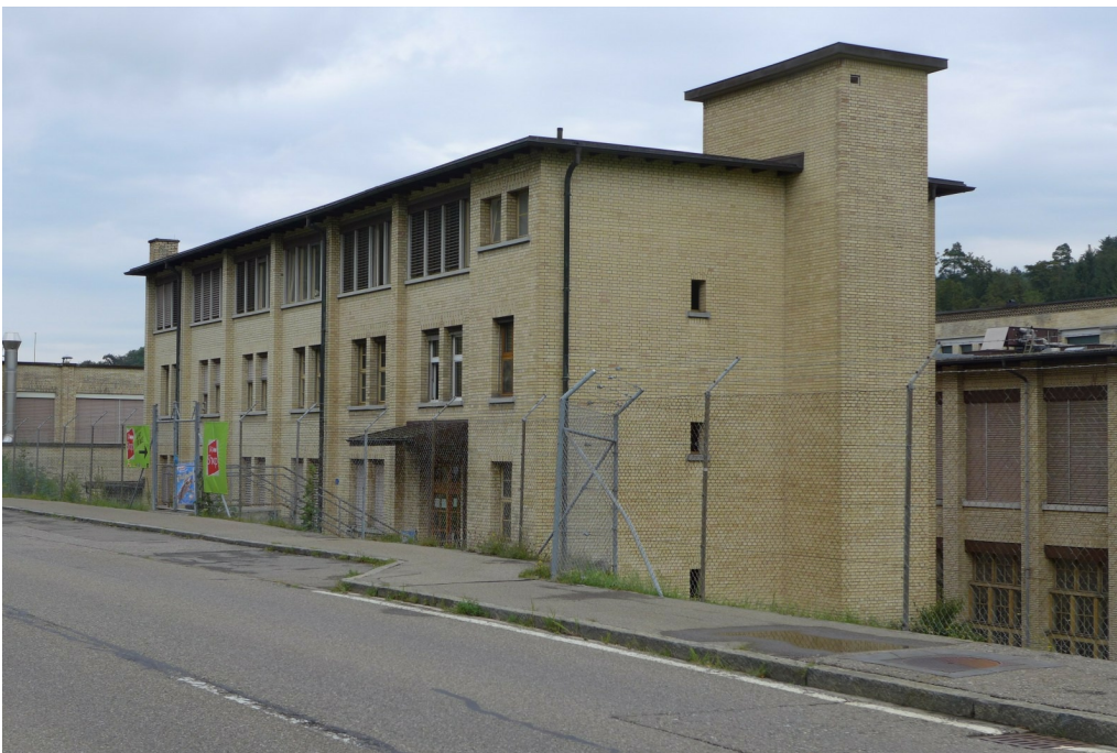
«Maggi-Areal», Betriebsbauten, Versuchsstation (Vers. Nr. 01262), Ansicht von SW, 29.08.2016 (Bild Nr. D101150_61).
