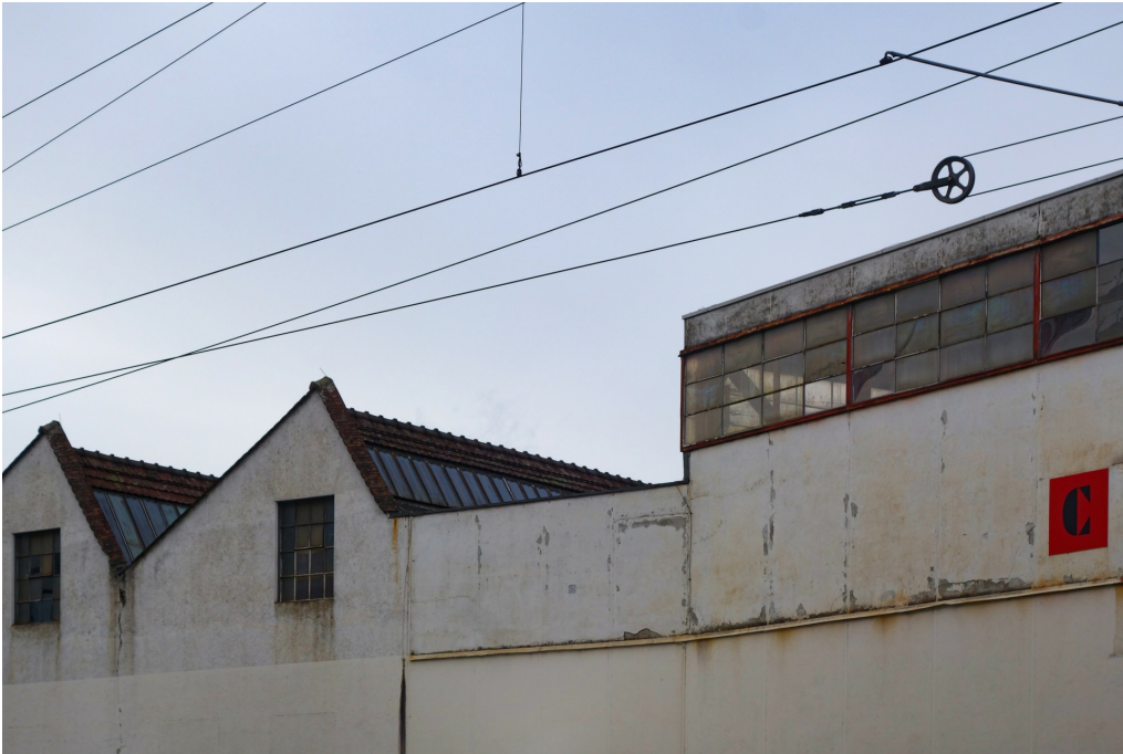
Fabrikhallen der ehem. Eisenbaugesellschaft Zürich, Übergang von der Montagehalle zur westlichen Querhalle, Detail der Dachgestaltung, Ansicht von SO, 05.12.2022 (Bild Nr. D101361_90).
