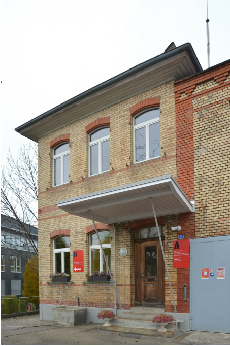
Fabrikhallen der ehem. Eisenbaugesellschaft Zürich, Verwaltungsgebäude, Ansicht von W, 17.11.2021 (Bild Nr. D101361_92).
