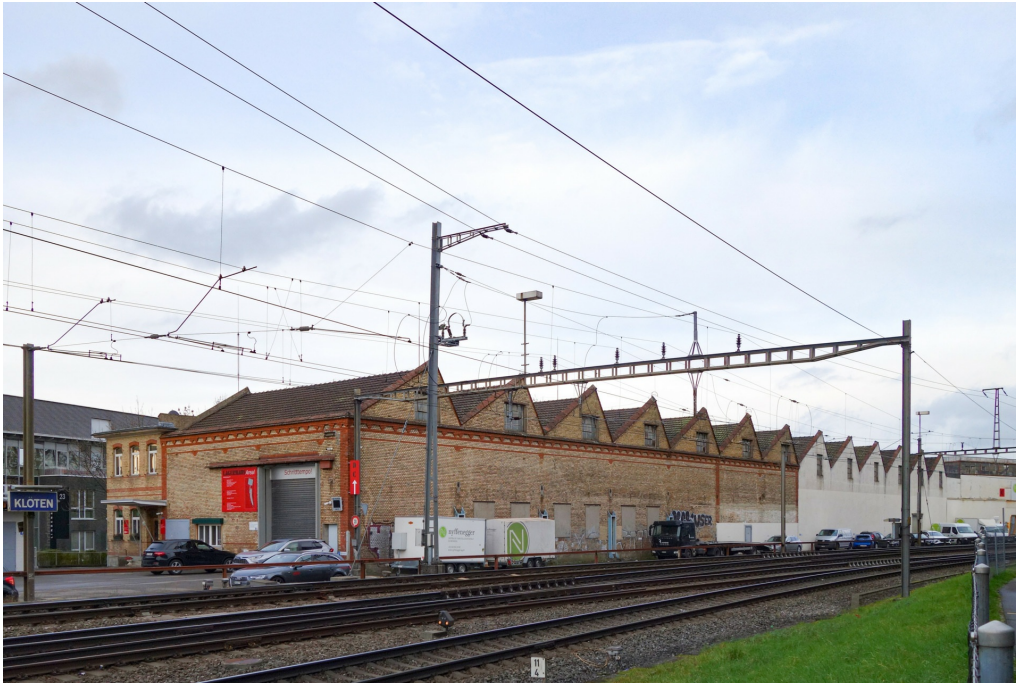
Fabrikhallen der ehem. Eisenbaugesellschaft Zürich, Ansicht von SW, 05.12.2022 (Bild Nr. D101361_84).
