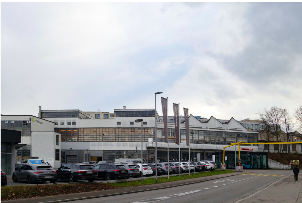
Fabrikhallen der ehem. Eisenbaugesellschaft Zürich, westliche Querhalle mit Zwischengebäude zur Montagehalle, Ansicht von N, 05.12.2022 (Bild Nr. D101361_97).
