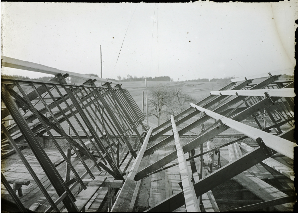
Fabrikhallen der ehem. Eisenbaugesellschaft Zürich, Detail der Sheddachkonstruktion, Ansicht von S, Bild: ETH-Bibliothek Zürich, Bildarchiv, Dia_258-013, 01.01.1902 (Bild Nr. D101361_81).
