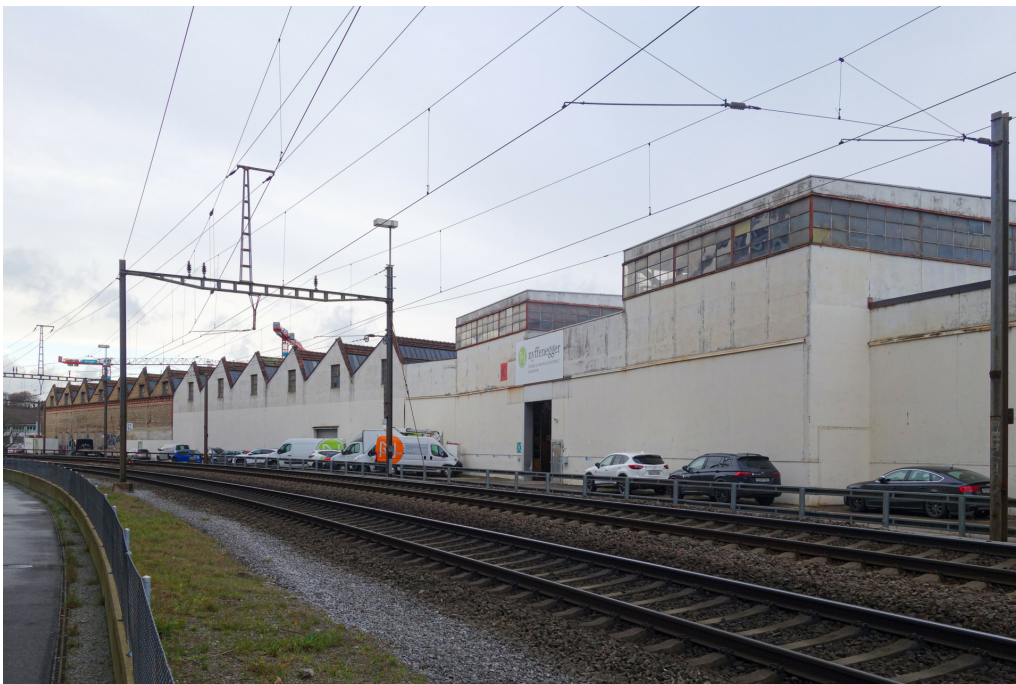
Fabrikhallen der ehem. Eisenbaugesellschaft Zürich, Montagehalle und westliche Querhalle, Ansicht von SO, 05.12.2022 (Bild Nr. D101361_89).
