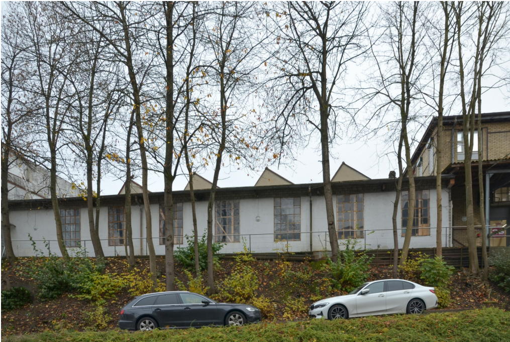
Fabrikhallen der ehem. Eisenbaugesellschaft Zürich, Anbau, Ansicht von N, 17.11.2021 (Bild Nr. D101361_96).
