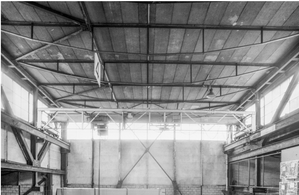
Fabrikhallen der ehem. Eisenbaugesellschaft Zürich, Innenaufnahme der westlichen Querhalle, Detail der Dachkonstruktion, Blick nach S, Bild: ETH-Bibliothek Zürich, Bildarchiv, SIK_01-033034, 01.01.1991 (Bild Nr. D101361_83).
