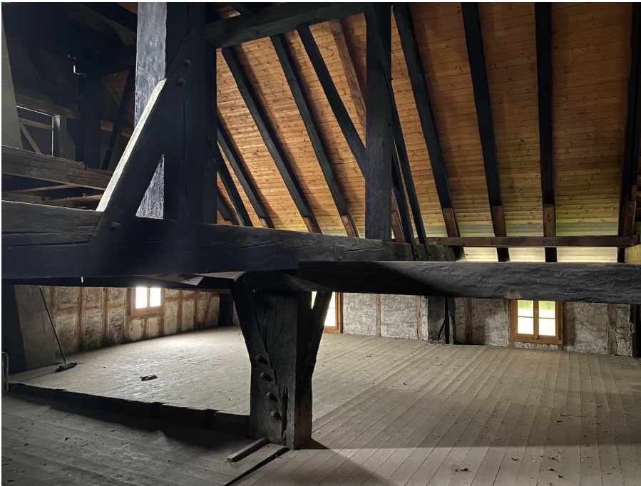
Ehem. Lehenhof des Klosters Kappel, rauchgeschwärzte Dachkonstruktion über dem Wohnteil, in der Mitte ein verblattetes Kopfholz mit gezahnter Kontur, Blick nach W, 27.08.2021 (Bild Nr. D100691_67).
