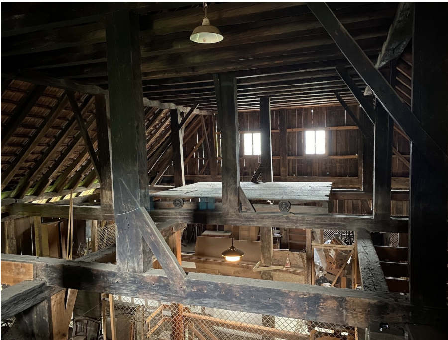
Ehem. Lehenhof des Klosters Kappel, Dachkonstruktion, Blick über das Tenn nach NO, 27.08.2021 (Bild Nr. D100691_65).
