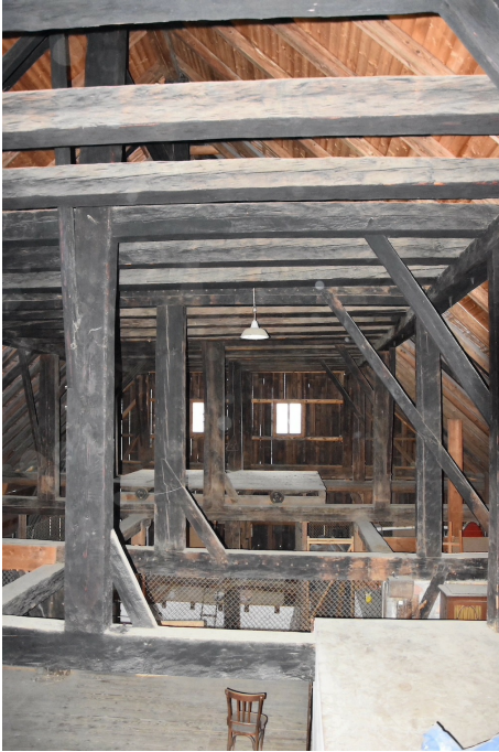
Ehem. Lehenhof des Klosters Kappel, Dachkonstruktion, hochstudartiges Dachgerüst (hohe Ständer tragen die Firstpfette), Blick vom Wohnteil nach NO, 27.08.2021 (Bild Nr. D100691_63).
