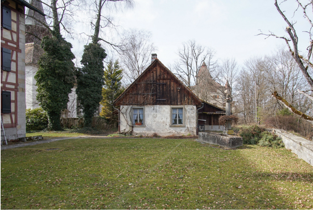
Ehem. Landschreiberei, Umgebung (296UMGEBU05325), Garten im NO des Wohnhauses, links die ehem. Landschreiberei (Vers. Nr. 05325), in der Mitte das Ökonomiegebäude (Vers. Nr. 05323) und der Brunnen (296BRUNNE05323), Ansicht von SO, 10.03.2021 (Bild Nr. D101111_69).
