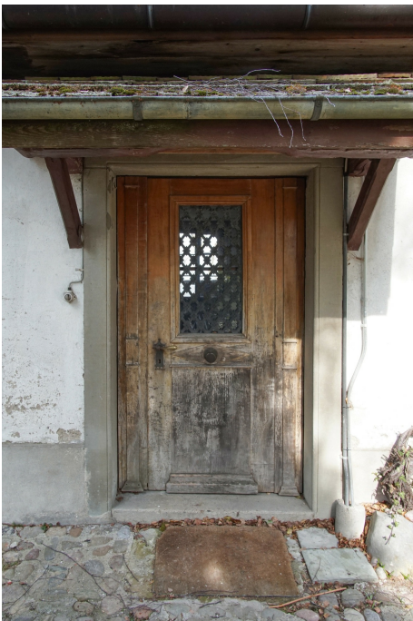
Ehem. Landschreiberei, Ökonomiegebäude (Vers. Nr. 05323), Eingang an der Südwestfassade, 10.03.2021 (Bild Nr. D101111_65).
