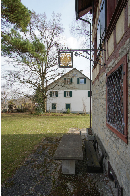
Ehem. Landschreiberei, Wohnhaus, ehem. Landschreiberei (Vers. Nr. 05325), Hausschild an der Nordostfassade, 10.03.2021 (Bild Nr. D101111_61).
