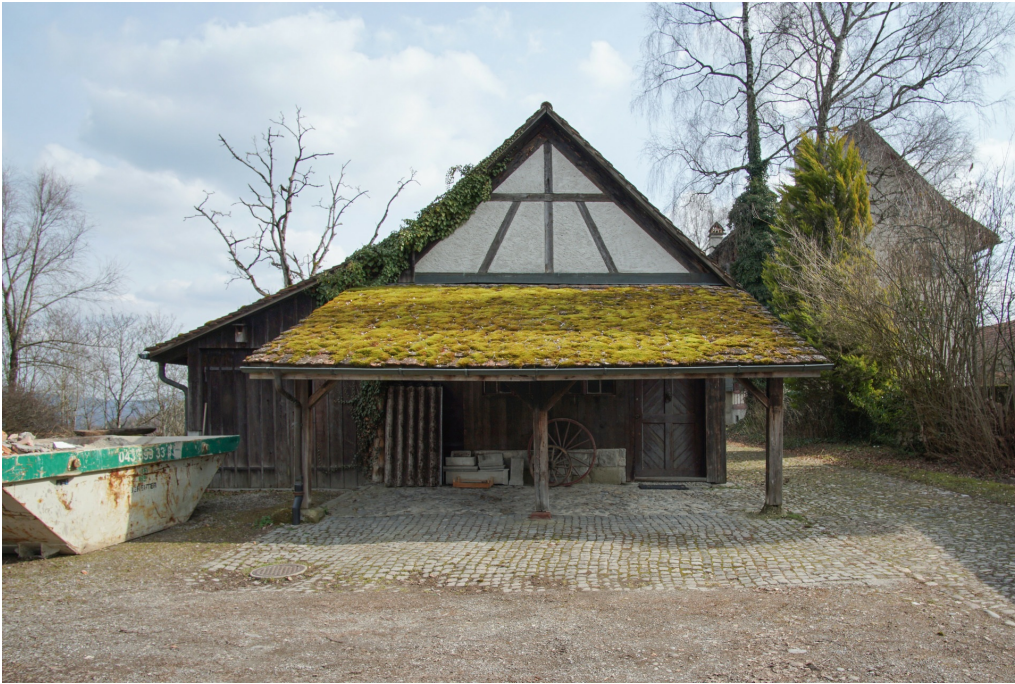
Ehem. Landschreiberei, Ökonomiegebäude (Vers. Nr. 05323), Ansicht von NW, 10.03.2021 (Bild Nr. D101111_66).
