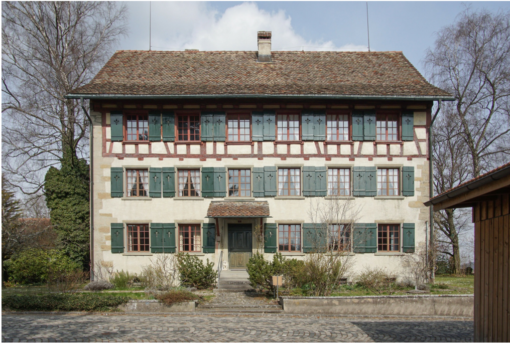
Ehem. Landschreiberei, Wohnhaus, ehem. Landschreiberei (Vers. Nr. 05325), Ansicht von SW, 10.03.2021 (Bild Nr. D101111_52).
