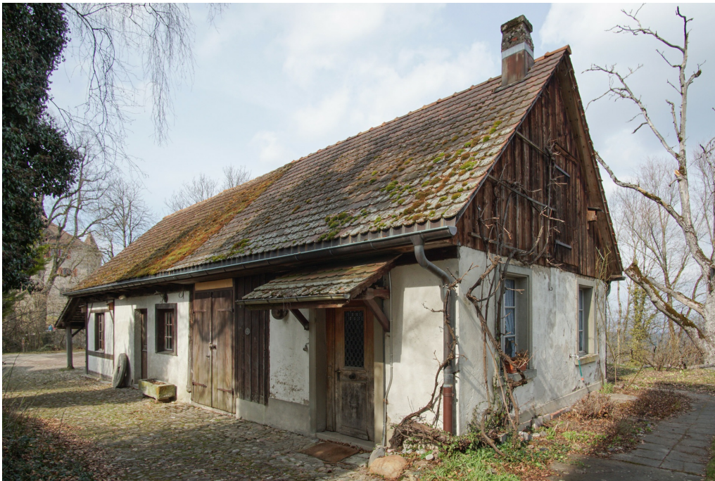
Ehem. Landschreiberei, Ökonomiegebäude (Vers. Nr. 05323), Ansicht von S, 10.03.2021 (Bild Nr. D101111_64).
