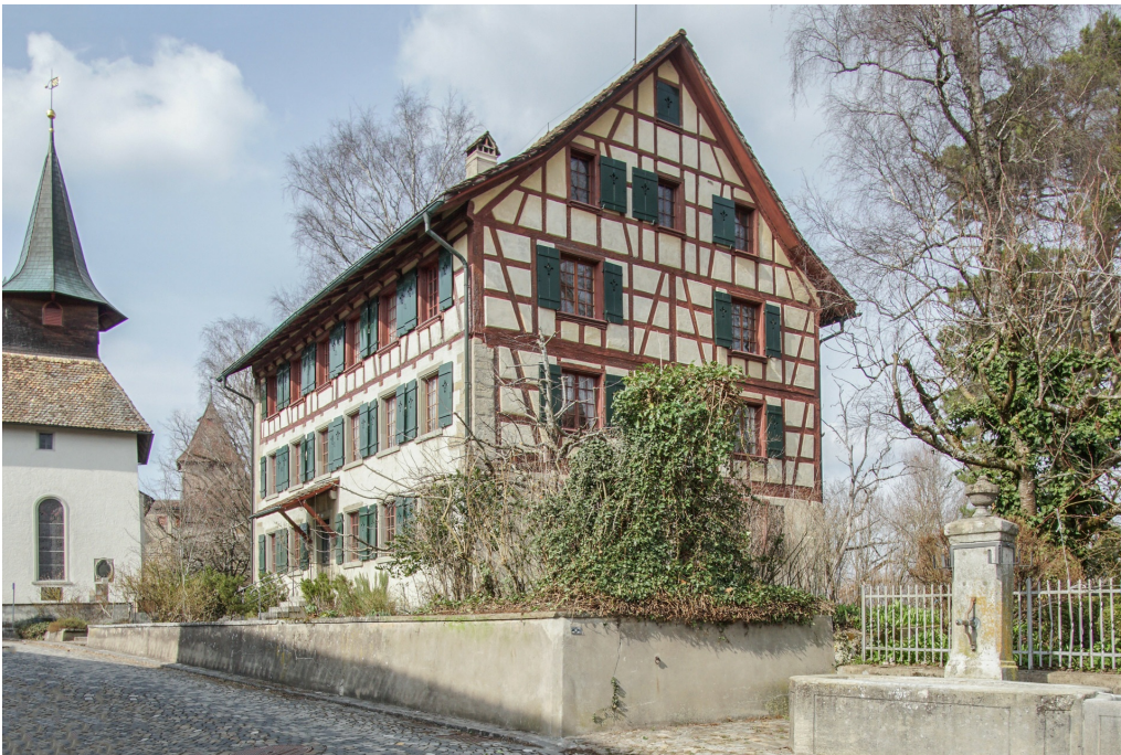
Ehem. Landschreiberei, Wohnhaus, ehem. Landschreiberei (Vers. Nr. 05325), Ansicht von SO, 10.03.2021 (Bild Nr. D101111_62).
