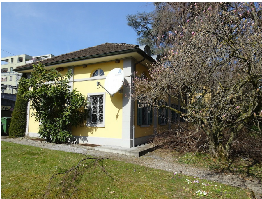
Remise (Vers. Nr. 00777), Südost- und Nordostfassaden, 29.03.2021 (Bild Nr. D100690_51).
