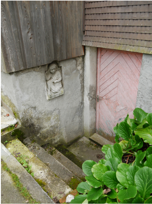
Wohnhaus Fischer, Kellerabgang, Ansicht von W, 10.10.2014 (Bild Nr. D100597_13).
