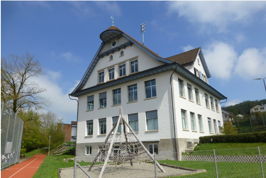
Primarschulhaus Güpf, Ansicht von S, 19.04.2016 (Bild Nr. D101084_01).
