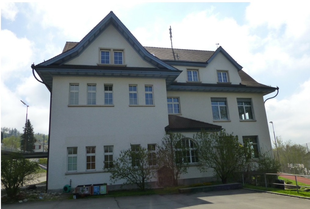
Primarschulhaus Güpf, Ansicht von NW, 19.04.2016 (Bild Nr. D101084_02).
