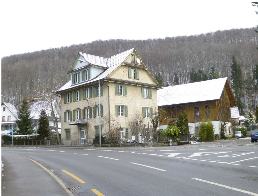
Wohnhaus «Zum Wiesenthal» mit Stallscheune, Ansicht Ensemble von SW, 14.01.2016 (Bild Nr. D101074_01).
