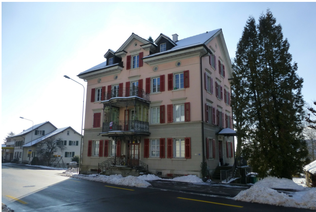
Wohnhaus «Brunnental», Ansicht von N, 21.01.2016 (Bild Nr. D101074_21).
