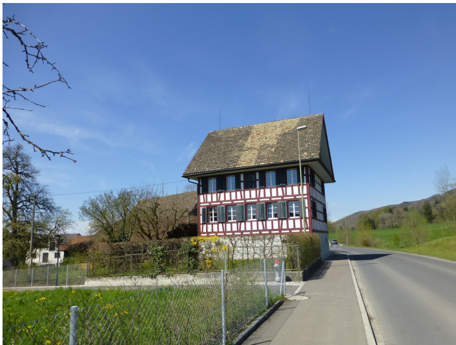
Wohnhaus mit Scheune, Wohnhaus (Vers. Nr. 00313), Ansicht von SO, 12.04.2016 (Bild Nr. D101083_11).
