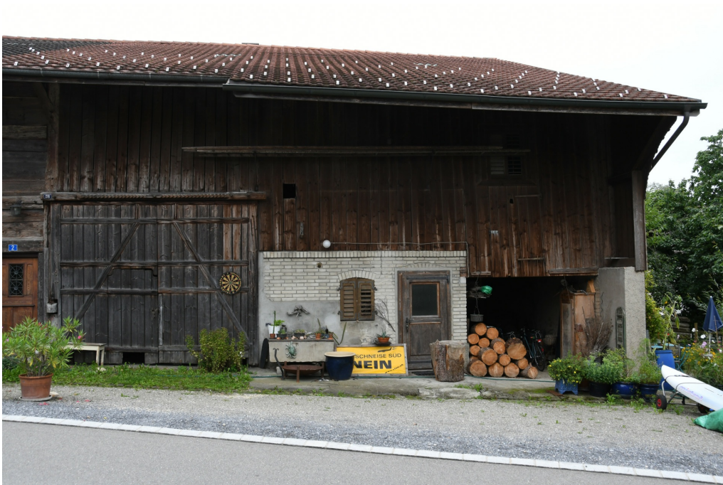
Vielzweckbauernhaus Im Hof, Nordwestfassade (Vers.-Nr. 00028), ab Tenntor nach rechts Erweiterung des Ökonomieteils 1645d–1648d, 22.08.2019 (Bild Nr. D100595_77).
