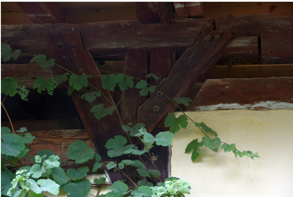
Vielzweckbauernhaus Im Hof, Südostfassade (Vers.-Nr. 00027), gezahnte, angeblattete Büge (Streben), die die äusseren Ständer an der Traufpfette mit Holznägeln fixieren, 22.08.2019 (Bild Nr. D100595_79).
