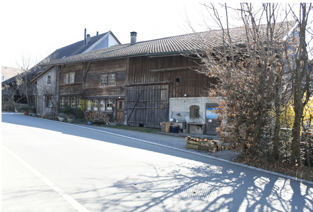
Vielzweckbauernhaus Im Hof, Nordwestfassade (Vers.-Nr. 00028), von links nach rechts: Schopf aus neuerer Zeit, Erweiterung 1617d–1619d, «Kernbau» 1544d–1545d, ab Tenntor Erweiterung des Ökonomieteils 1645d–1648d, 23.03.2022 (Bild Nr. D100595_80).
