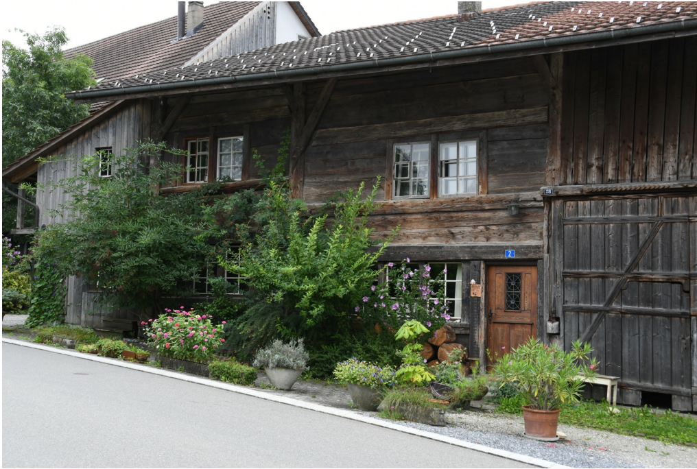
Vielzweckbauernhaus Im Hof, Nordwestfassade (Vers.-Nr. 00028), von links nach rechts: Schopf aus neuerer Zeit, Erweiterung 1617d–1619d, «Kernbau» 1544d–1545d, 22.08.2019 (Bild Nr. D100595_76).
